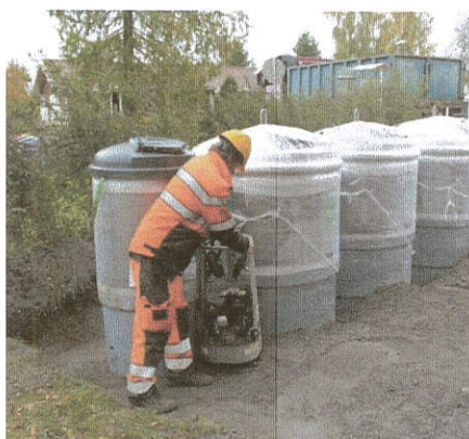
Obrázek 3.5. Zhutnění zásypu a položení vrchní pochozí plochy okolo kontejnerů.
