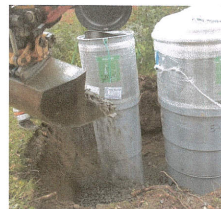
Obrázek 3.4. Zasypejte okolí kontejnerů štěrkem nebo jinou zeminou o zrnitosti 16 – 32 mm.
