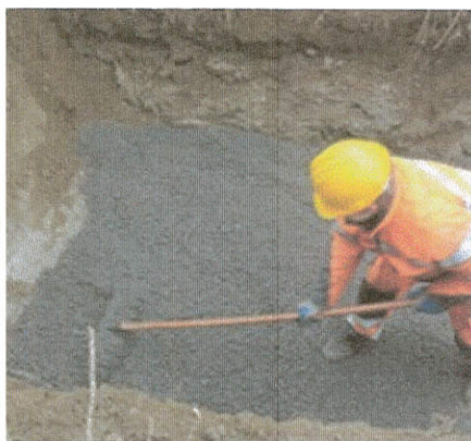
Obrázek 3.1. Vyrovnání dna výkopu vrstvou drceného šterku 0-16 mm o síle 50 mm.
