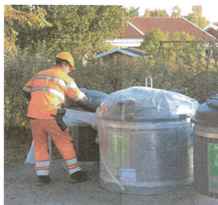
Obrázek 3.6. Odstranění ochranného igelitu.
