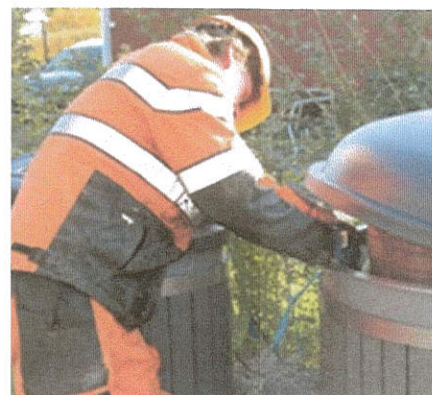
Obrázek 3.7 Demontujte montážní úchyty.
