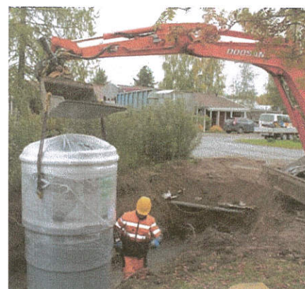
Obrázek 3.3. Umístěte kontejner do stavební jámy za pomoci úchytů a lana/řetězu. Ujistěte se, že stojí kontejner rovně.
