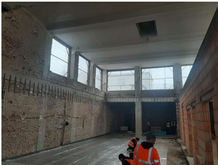
Obrázek 39 a 40: Rekonstrukce prostor pro Onkologické centrum, FTN - výstavba a vizualizace
