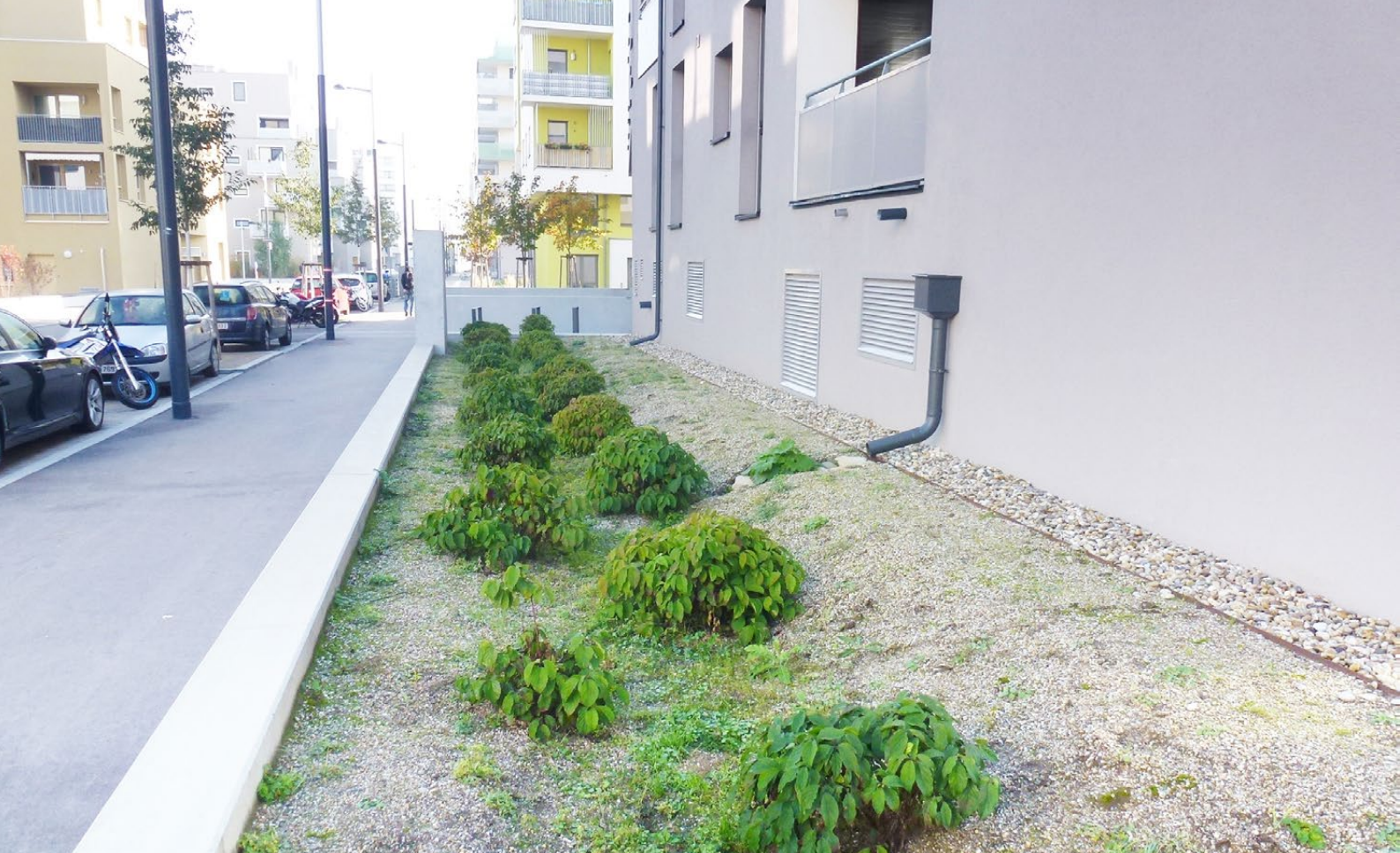
Jezerní město Aspern, nové město na zelené louce. Důsledné a systémové hospodaření s dešťovou vodou. Voda zůstává v území. Svody z plochých střech ústí do vsaků a průlehů v rámci zahradních úprav parteru. Eliminace tepelných ostrovů.
