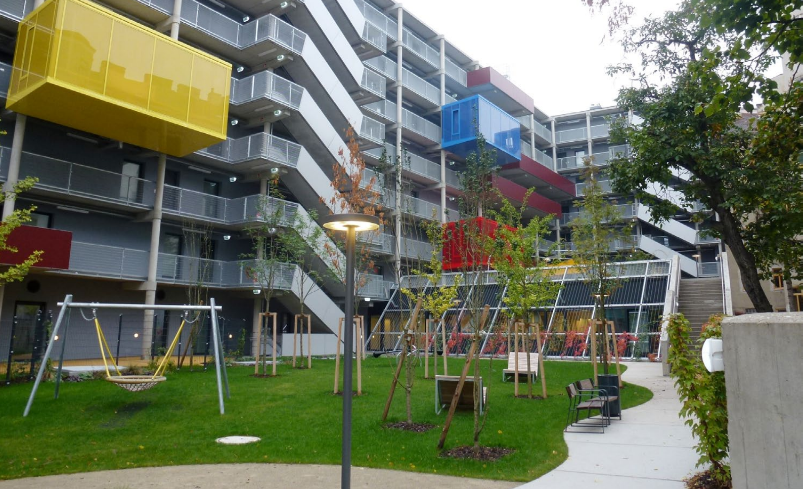
Vnitřní městská přestavbová zóna Hauptbahnhof, Alfred Adler Strasse, dostavba stávajícího bloku činžovních domů. V parteru parková úprava, z atrii a výkladů přisvětlené komunitní a komerční prostory. Pavlačový koncept s navěšenými transparentními barevnými boxy pro kola – nevytápěné prostory.
