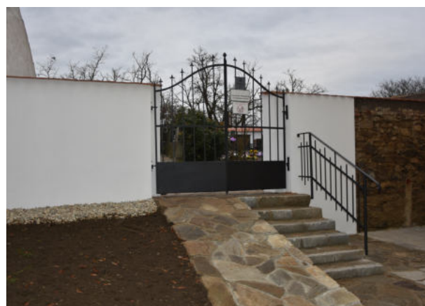
Oprava vstupní brány ke hřbitovu, zpřístupnění hřbitova hendikepovaným a úprava zelených ploch (Popice)
