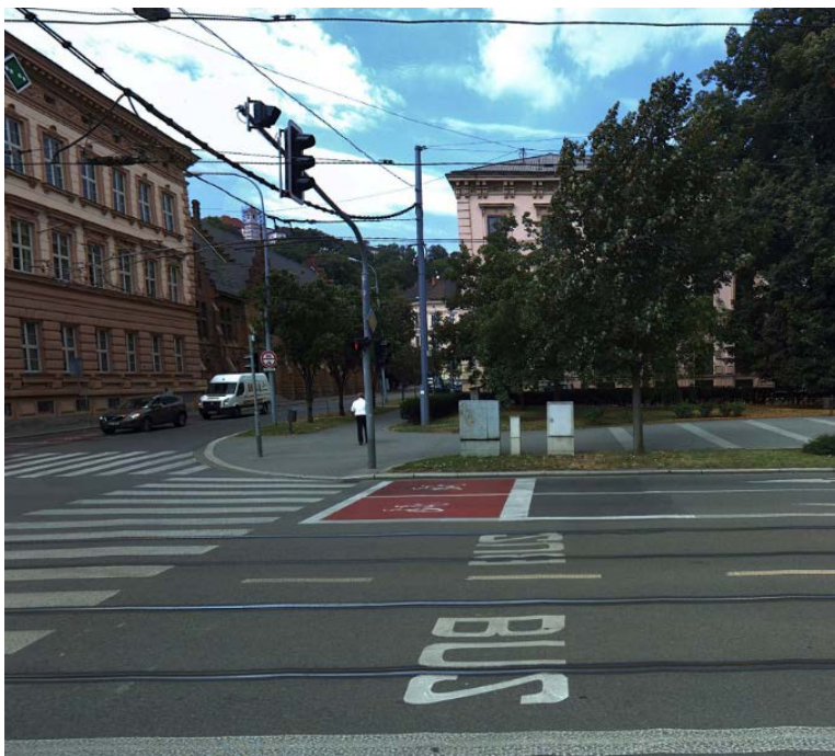
Obrázek 39 -Předsunuté stopčáry na křižovatkách se světelnou signalizací v Brně
