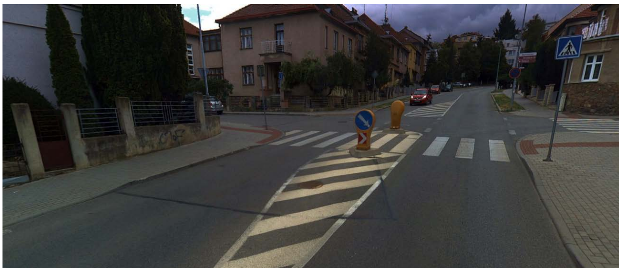
Obrázek 30 - Příklad bezbariérové úpravy přechodu pro chodce
