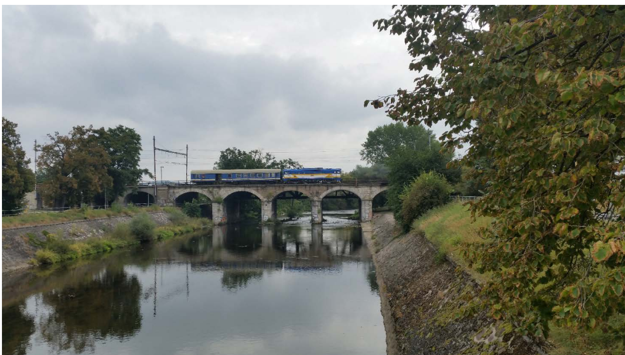
Obrázek 21 - Železniční most u Štýřického nábřeží
