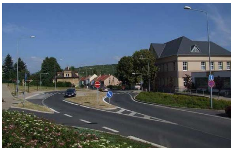
Obrázek 50 - Ukázka vjezdové brány, Obrnice
