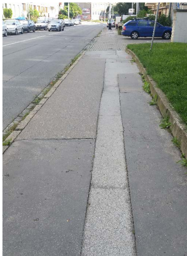
Obrázek 29 – Příklady nevhodně provedených chodníků
