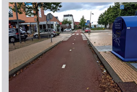
Obousměrný cyklistický pás v přidruženém prostoru (stežka pro cyklisty) výškově oddělený od ploch pro pěší.
