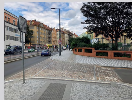
Příklad zachování výškové kontinuity chodníku v místě přecházení přes boční komunikaci.
