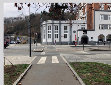
Příklad přejezdu pro cyklisty přimknutý k přechodu pro chodce.
