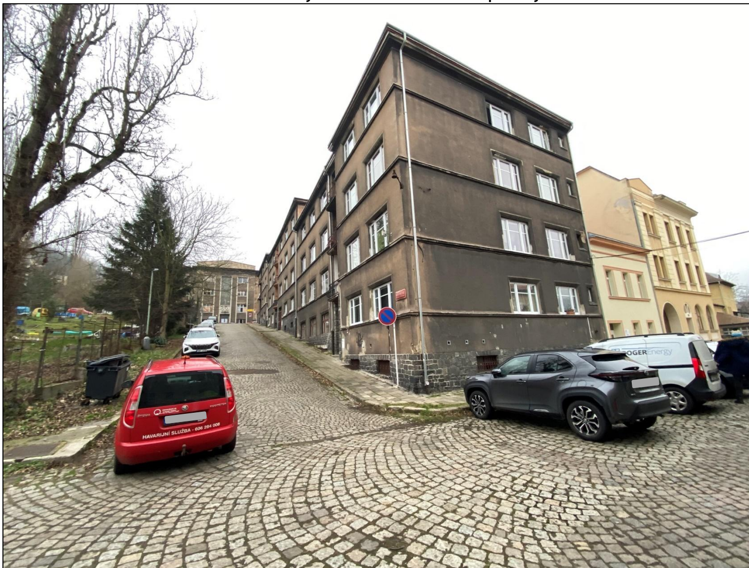
Obr. 39: Fotodokumentace zástavby v okolí kritického místa priority II v ulici Bratří Mrštíků
