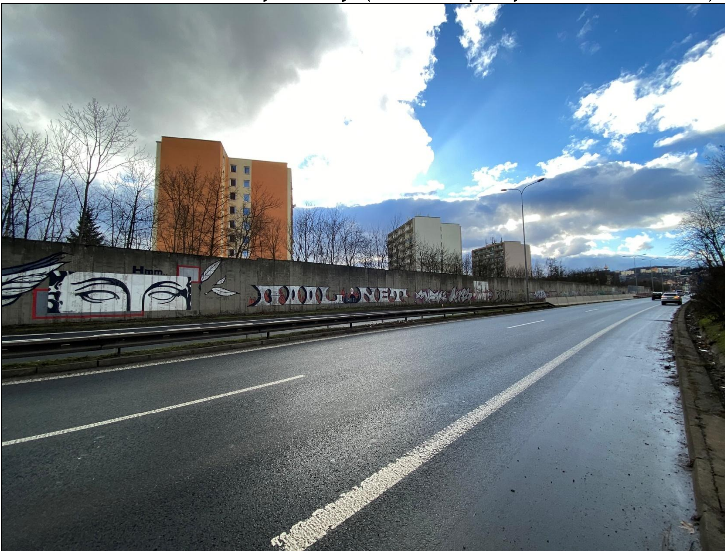
Obr. 20: Fotodokumentace zástavby v ulici Alejní (kritické místo priority II s označením AGULRD004)
