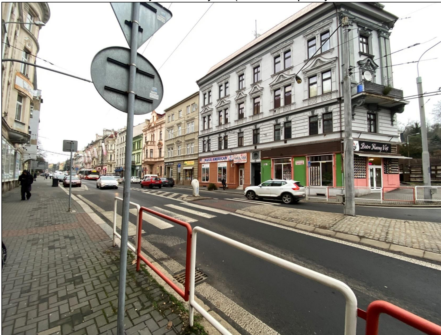
Obr. 22: Fotodokumentace zástavby v ulici Masarykova (kritické místo priority II s označením AGULRD007)
