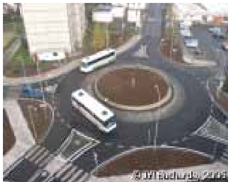
Obr. 8 – Výstavbou okružní křižovatky v 2006 byla vyřešena složitá a nepřehledná křižovatka ulic Pražská, Kmochova, Karolíny Světlé v centru města. Na celkové investici cca 13 mil. Kč se podílel Ústecký kraj (2/3) a město Varnsdorf (1/3).
