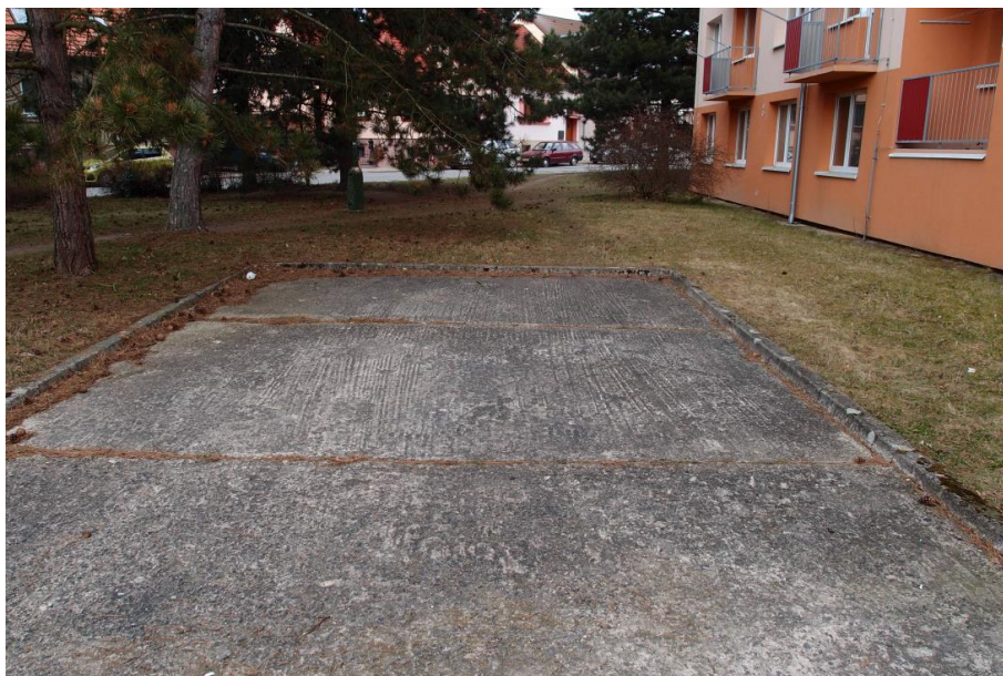
Obrázek 3: Proměna zpevněného povrchu parkoviště např. s využitím roštu nebo dlažby se širokou spárkou může pomoci zlepšit kromě estetických vlastností okolí i mikroklima. V tomto místě by bylo možno transformovat 300 – 500 m 2 zpevněných ploch.
