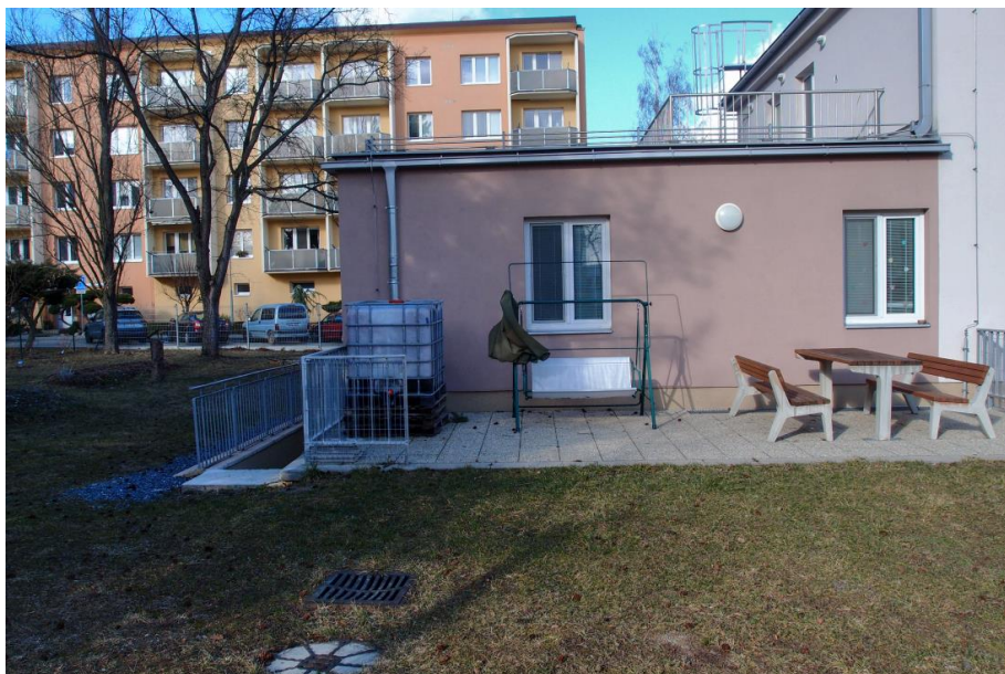
Obrázek 7: Už nyní je prováděno zachytávání dešťové vody z části střechy do nadzemní nádrže. Instalací podzemní nádrže o objemu 10\text{ m}^3 by bylo možno získat výrazně více vody nejen pro zalévání zeleně na okolním pozemku (cca 5000\text{ m}^2 ), ale také například pro budoucí využití v samotném objektu.
