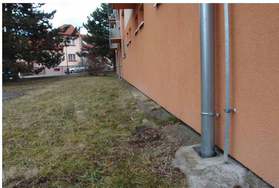
Obrázek 2: Vnější svody dešťové vody umožňují snadné napojení na případnou budoucí akumulční nádrž.
