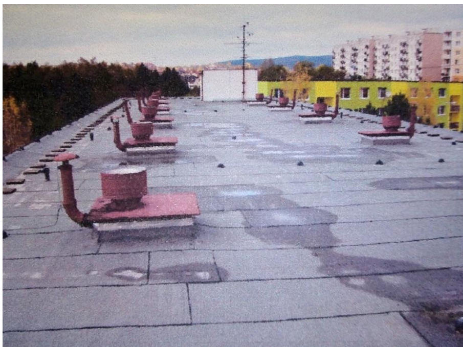
Obrázek 4: Reprodukce fotografie z průkazu energetické náročnosti budovy ukazuje současné řešení odvětrání jader bytů s hlavicemi a patrná je i vpusť pro dešťovou vodu, která je odváděna vnitřkem budovy. Detaily řešení odvádění srážkové vody z objektu jsou klíčové pro možnost zasakování či akumulace vody v okolí.
