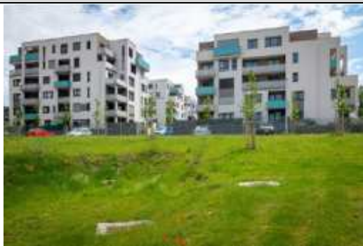
Vsakovací retenční nádrž, SUOMI Hloubětín, Praha
