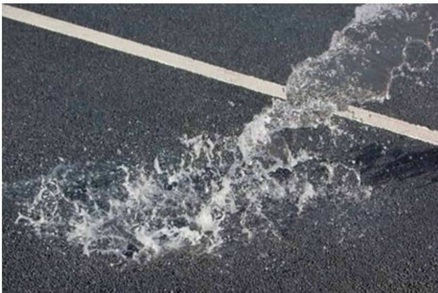
Propustný asfalt: https://eurozpravy.cz/veda-a-technika/veda/132647-povodne-uz-nejsou-problem-chytry-beton-absorbuje-vodu/
