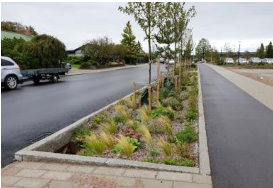
Prostor pro vsakování dešťové vody. Zdroj: Livable Streets - A Handbook of Bluegreengrey Systems Version 2.0
