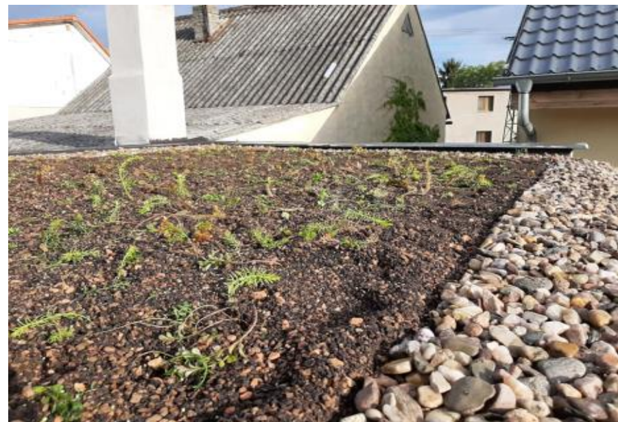
Čerstvě založená extenzivní zelená střecha, Rudná (Foto CI2, o. p. s.)
