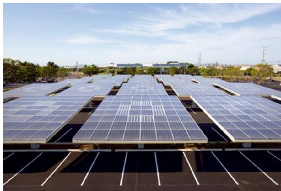
Stínění pomocí FVE panelů. ( https://www.asb-portal.cz/stavebnictvi/technicka-zarizeni-budov/fotovoltaika/solarni-parkoviste-vice-uzitku-zjedne-instalace )
