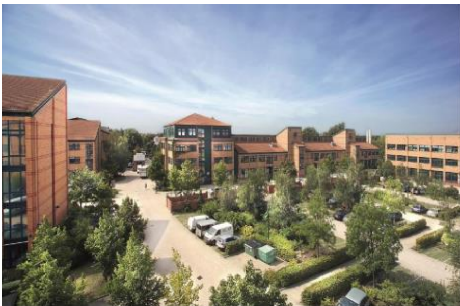
Revitalizace brownfields ( https://ct24.ceskatelevize.cz/regiony/1929104-z-arealu-byvale-zbrojovky-bude-za-deset-let-moderni-brnenska-ctvrt )
