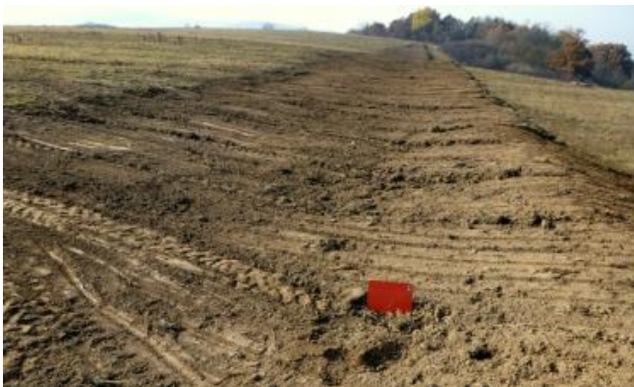
Realizace průlehu, Okružle
