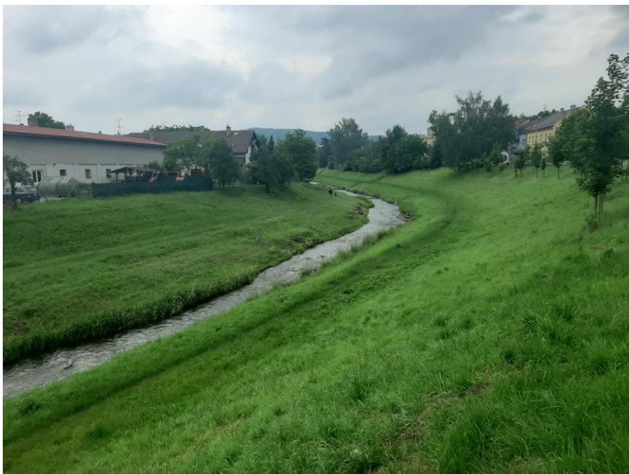
Koryto Jičínky – protipovodňový val. Foto: CI2, o. p. s.
