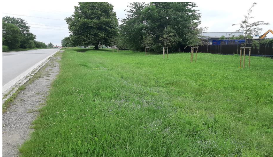
Vsakovací průleh. Nový Jičín, ulice Suvorovova (foto CI2, o. p. s.)
