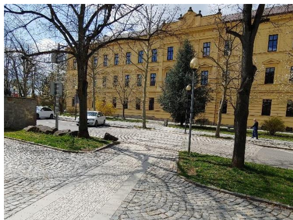
Příklad komfortního přechodu na širokém příčném prahu.
