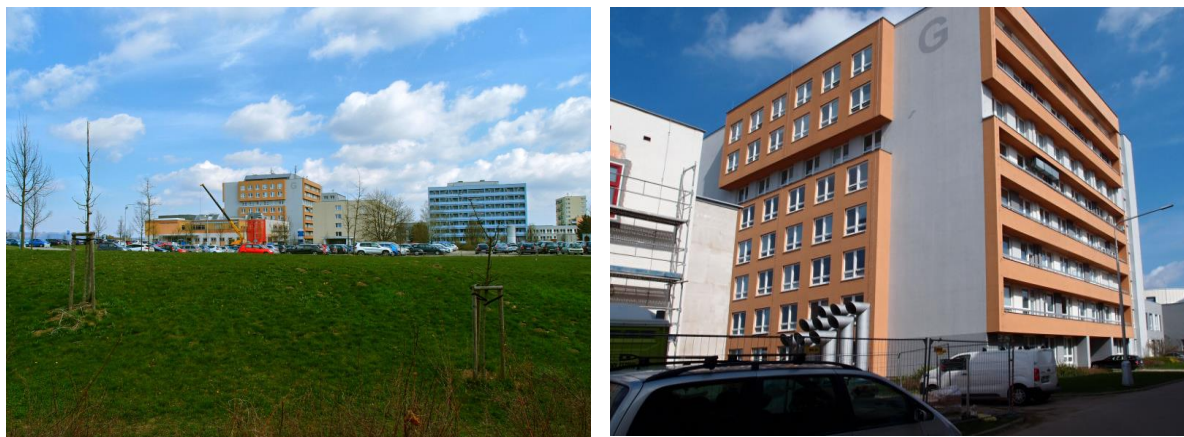
Obrázek 29: Průčelí pavilonů nemocnice orientovaná na jih nejsou chráněna proti přímému slunci
