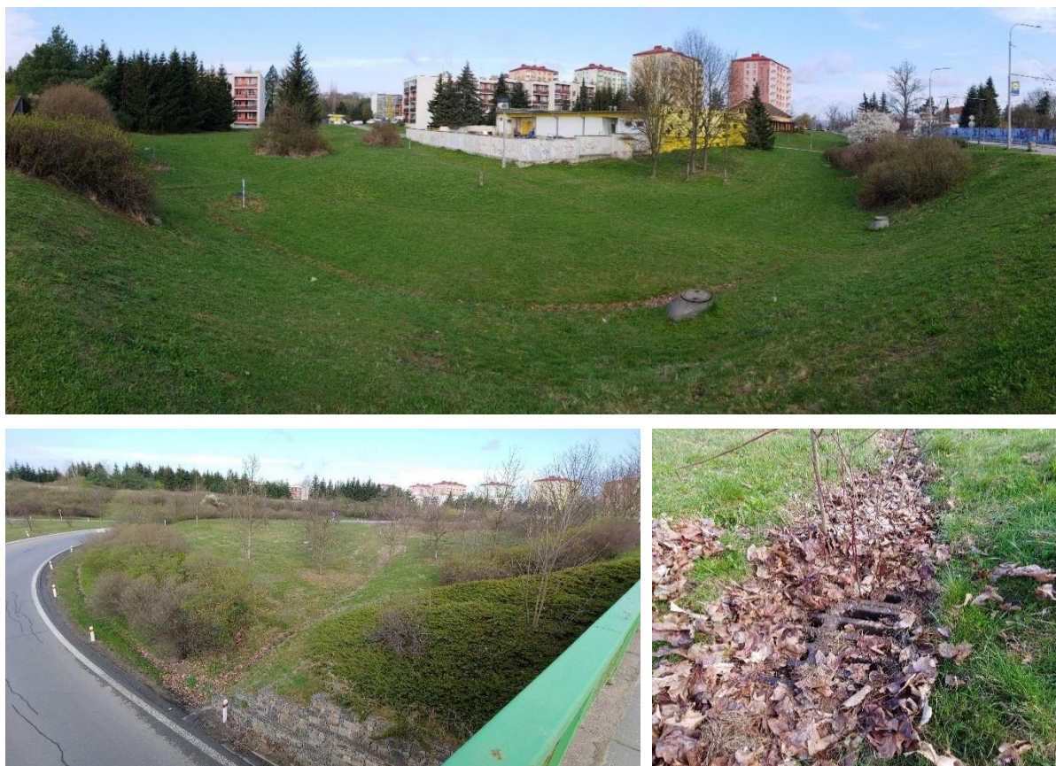
Obrázek 26: Vegetační plochy odvodněné dešťovou kanalizací místo využití dešťových zahrad či průlehu k retenci a zasakování
