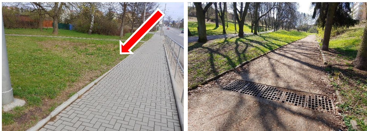
Obrázek 25: Různé přístupy k dešťové vodě z chodníku
