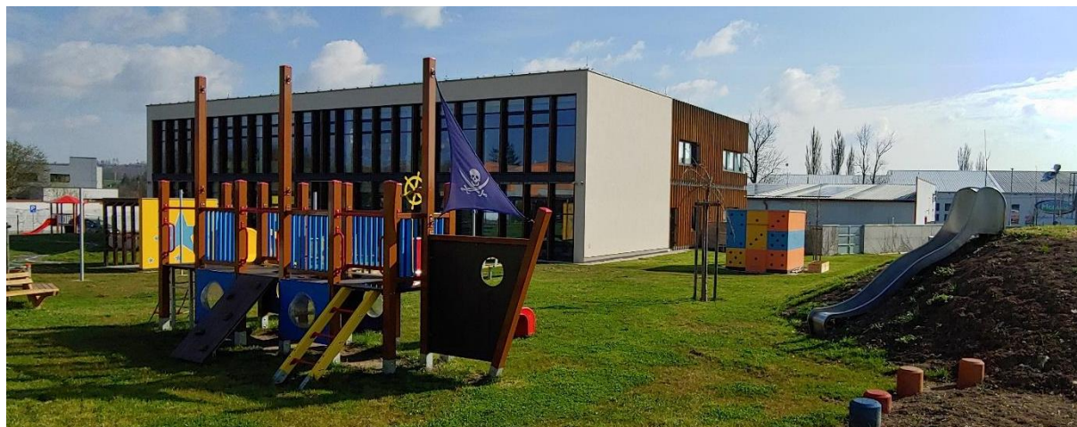
Obrázek 2172: Nevhodná dispozice MŠ Bystrouška v ulici Na Dolech
