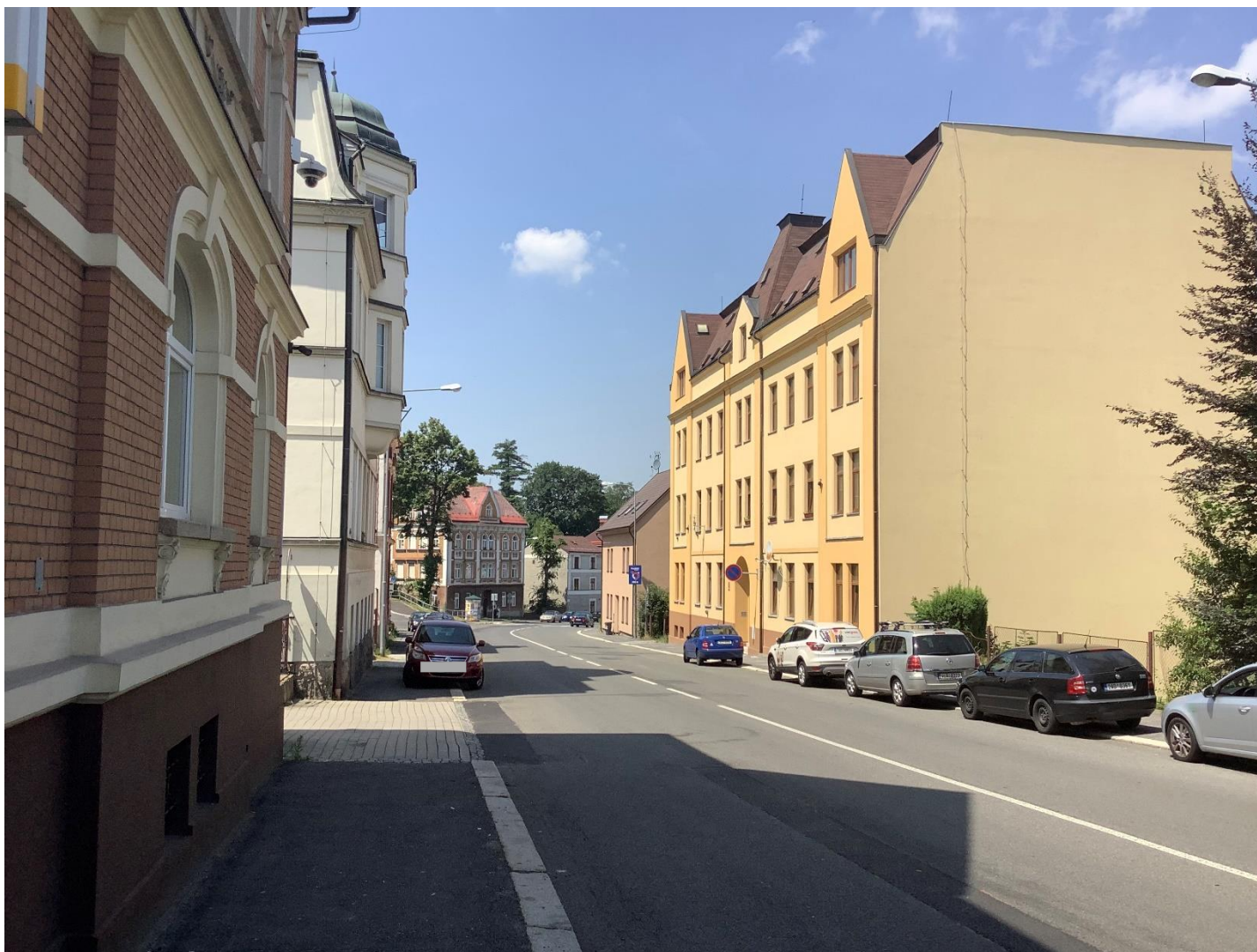
Obr. 26: Fotodokumentace zástavby v okolí kritického místa č. 9 priority I v Jablonci nad Nisou
