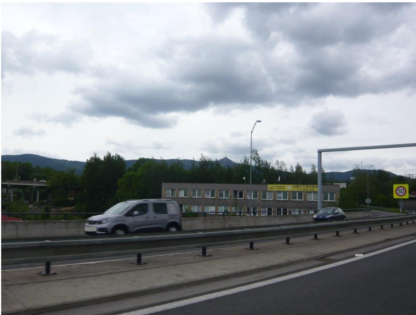
Obr. 19: Fotodokumentace víceúčelové stavby (ubytovny) nacházející se v kritickém místa č. 5 priority I v Liberci
