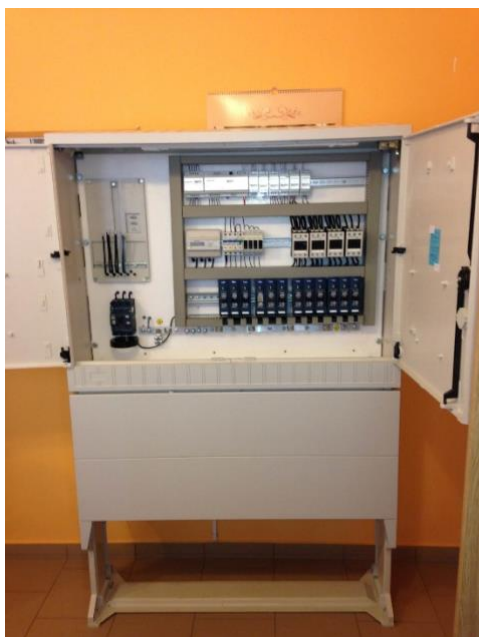
Obr. Nový rozvaděč RVO s řídicími rozvodnicemi
