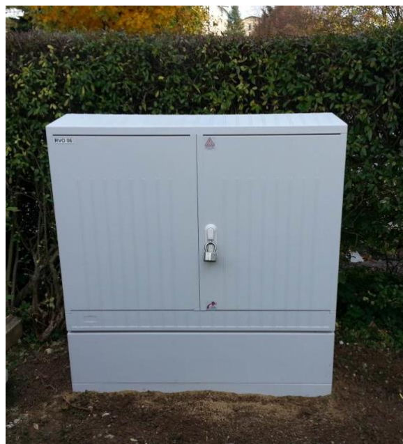
Obr. Nový rozvaděč RVO s řídicími rozvodnicemi
