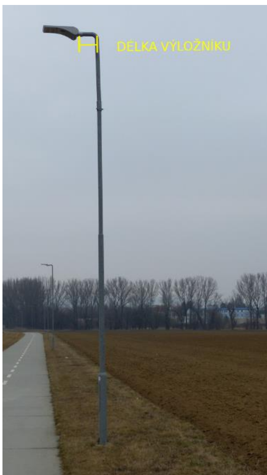
Obr. 2 Určování rozměrů světelného bodu – délka výložníku
