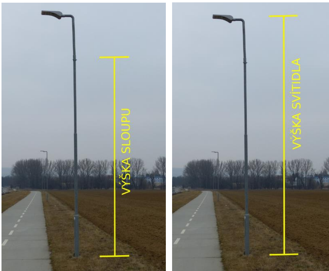
Obr. 1 Určování rozměrů světelného bodu – výška sloupu a výška svítidla
