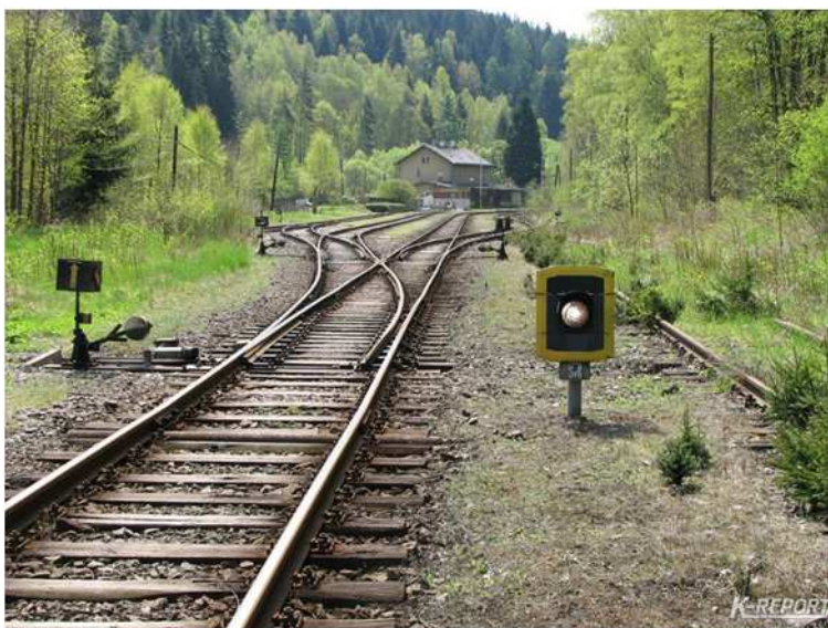
Obr. Vlevo nahoře: výhybka se samovratným přestavníkem, foto: Tomáš Lajbl, http://vlaky.bestsite.cz
