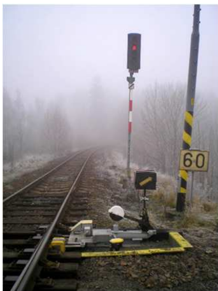
Obr. Vlevo nahoře: výhybka se samovratným přestavníkem, foto: Tomáš Lajbl, http://vlaky.bestsite.cz
