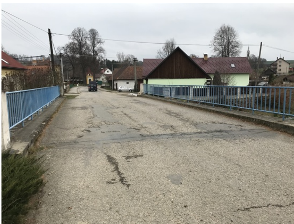
Obr. 45 - Závada na mostě v místní části Kletečná
