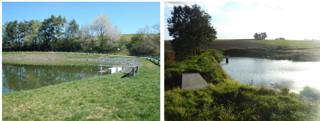
Obr. 36: Nová malá vodní nádrž u obce Onšov (vlevo), starý rybníček u Kyjova na Vysočině
