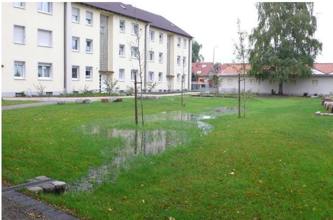
Obr. 3: Vsakovací prostor u obytných objektů – zdroj: http://www.fpg-herne.de/
