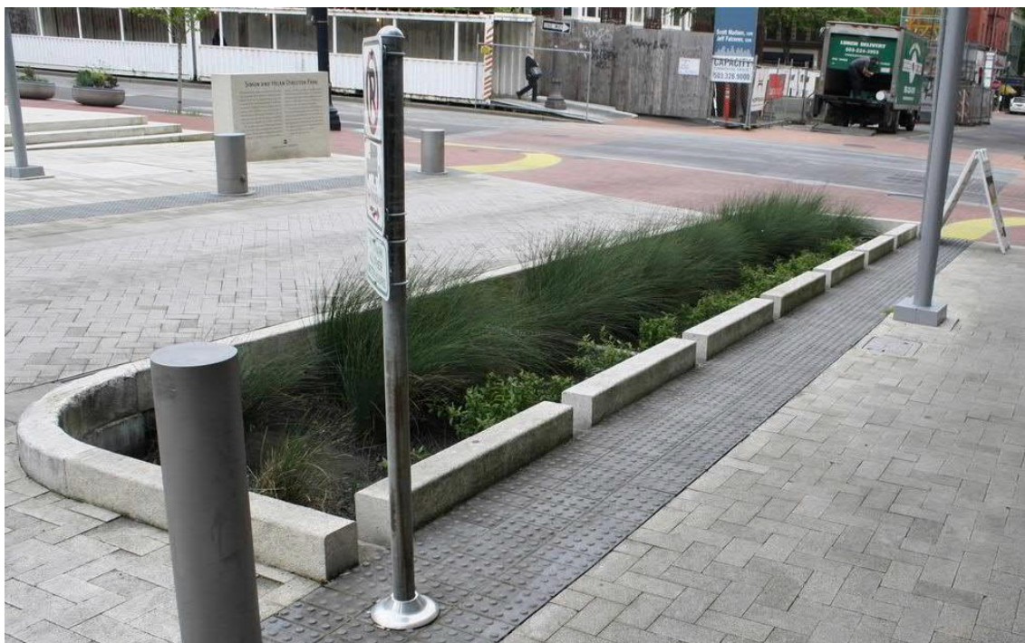
Obr. 15: Vsakovací retenční rýha s povrchovým přítokem – zdroj: http://www.landperspectives.com
