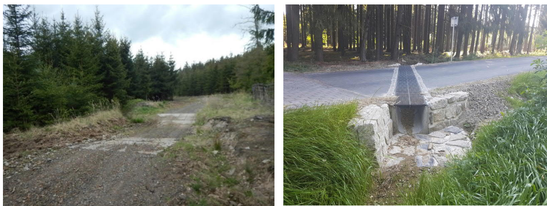
Obr. 32: Cestní průleh pro rozptýlení soustředěného odtoku – příklad z lesů v majetku města Hostomice a z k.ú. Níhov (Zdroj SPÚ)
