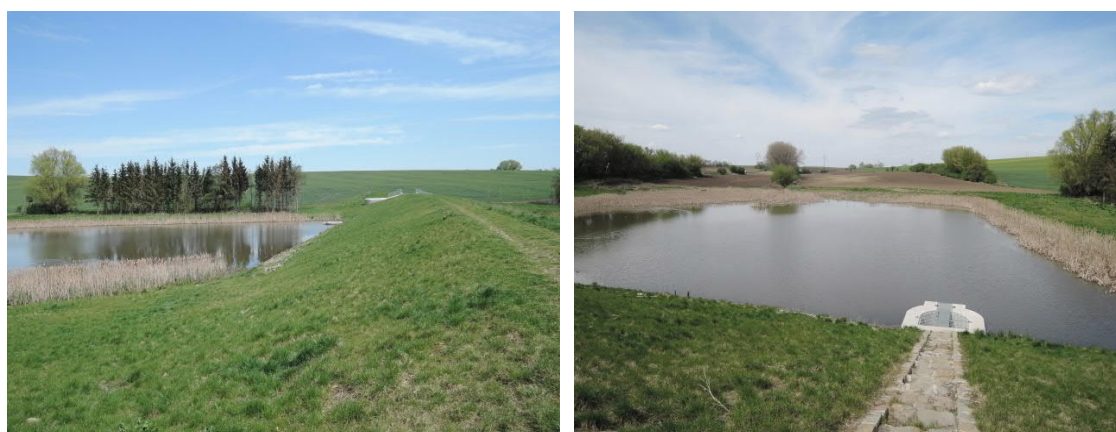
Obr. 40: Příklad realizované polosuché nádrže v obci Prušánky
