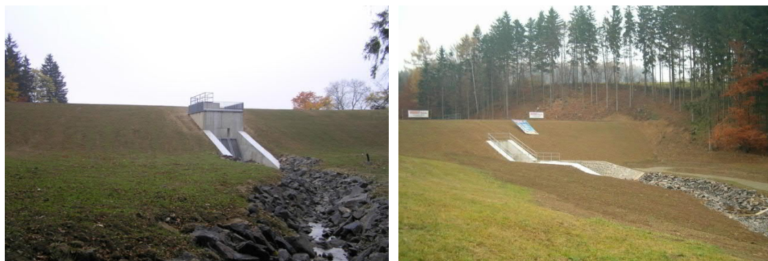
Obr. 38: Příklad realizované SN Čermná v Pošumaví (sdružený objekt, odtokové koryto)
