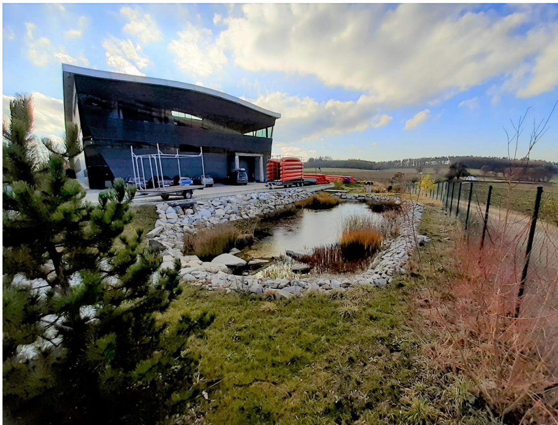
Obr. 17: Malá retenční nádrž u průmyslového objektu u obce Jíloviště
