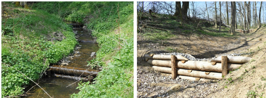
Obr. 27: Malý příčný objekt na Křivoklátsku a srubová přehrážka u Hradčan na Moravě (zdroj: Sweco, prerovsky.rej.cz)
