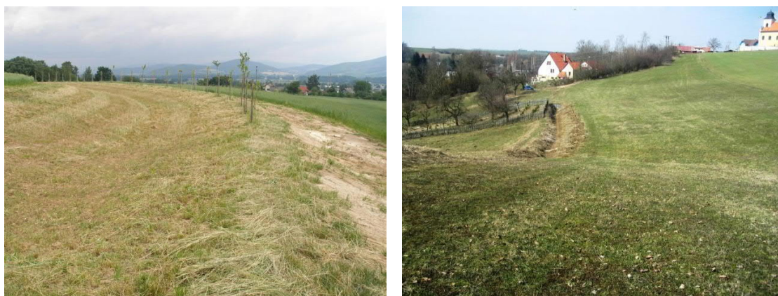
Obr. 19: Zatravněný retenční průleh u města Zábřeh na Moravě (zdroj http://www.zabreh.cz/ ), záchytný příkop nad pozemkem na okraji intravilánu obce
