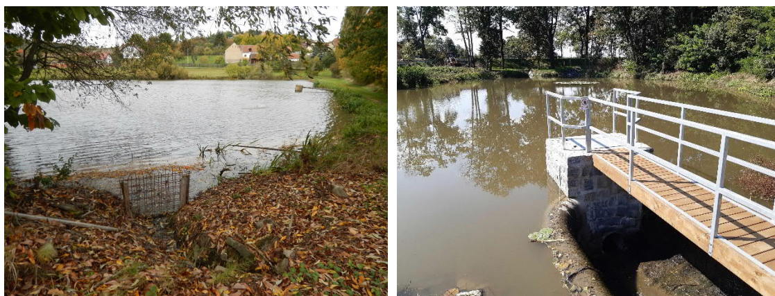
Obr. 42: Příklad malé vodní nádrže u Písku bez bezpečnostního přelivu a oproti tomu revitalizované nádrže na Jesenickém potoce ve Zdiměřicích
