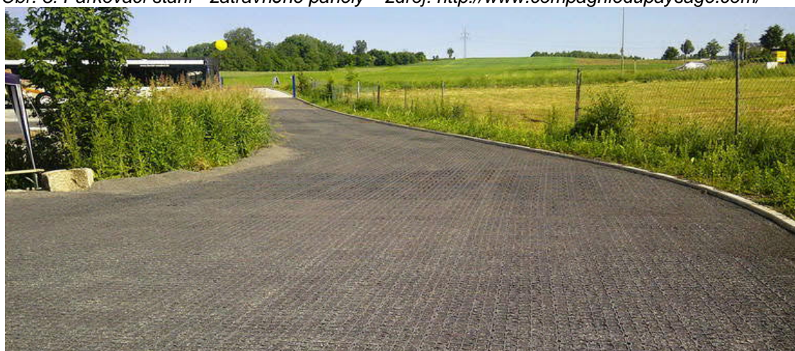
Obr. 6: Příjezdová cesta - rošty vyplněné štěrkem – zdroj: https://www.ecoraster.cz/
