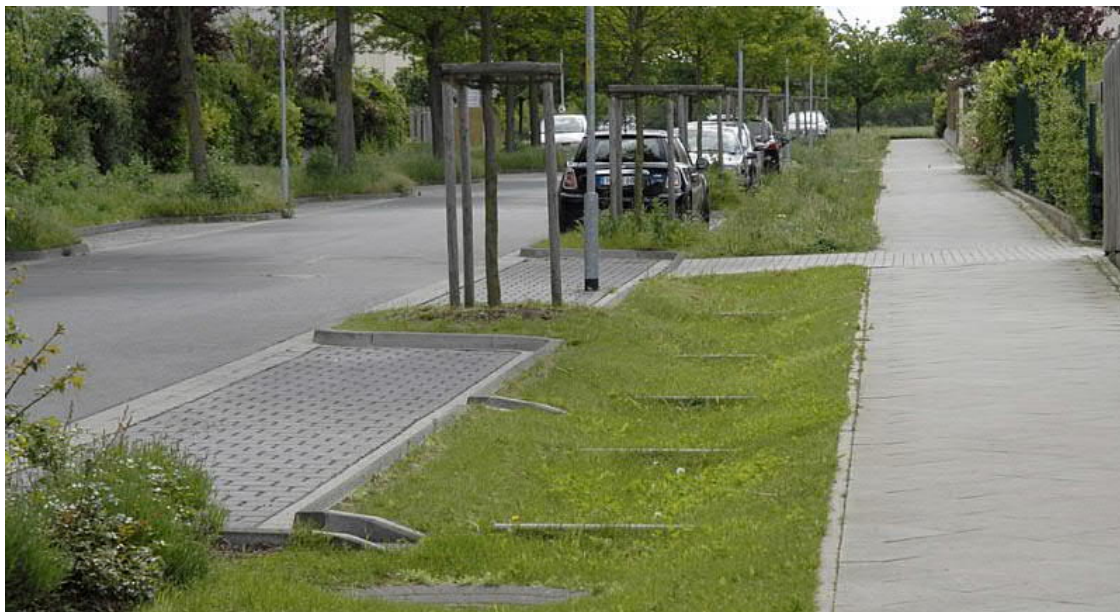
Obr. 2: Parkovací stání s příčným sklonem směrem k trávniku (vsakovací příkop) s mělkými prohlubněmi – zdroj: https://www.hamburg.de/
