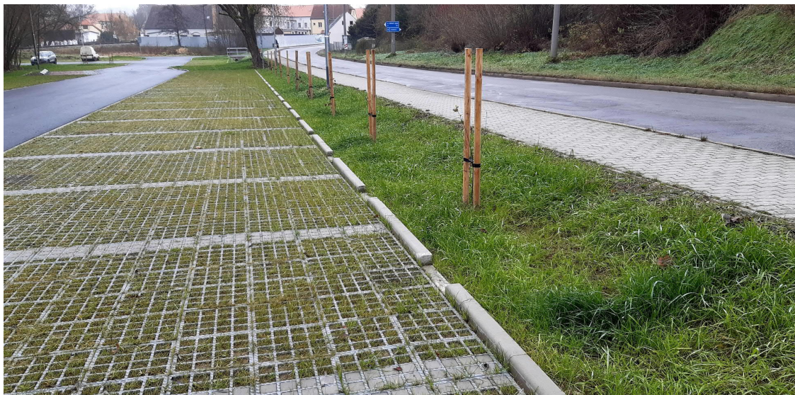
Obr. 4: Parkovací stání využívající zatravněné panely v Dačicích
