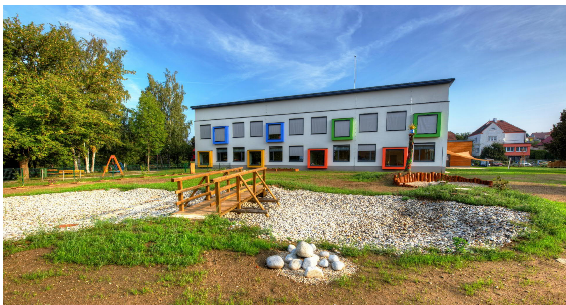
Obr. 7: Vsakovací průleh – Dačice, MŠ Za Lávkami
