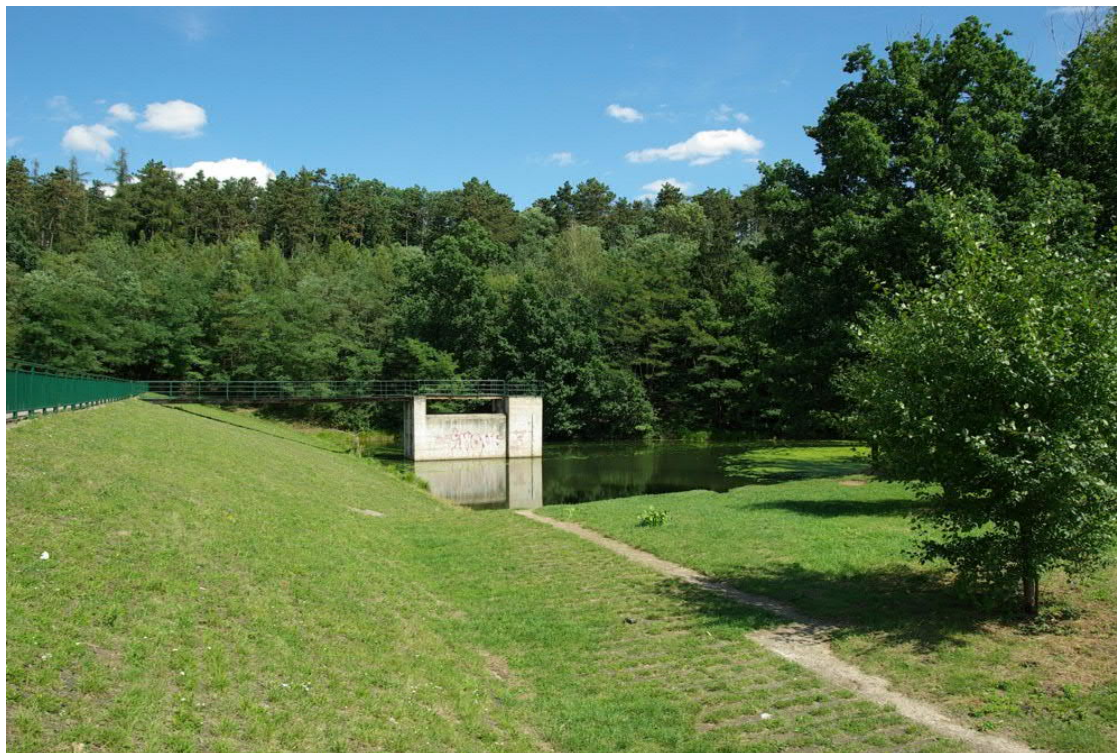
Obr. 41: Příklad retenční nádrže z Prahy – Modřan, sdružený objekt s dlužovou stěnou (zdroj: http://www.praha-priroda.cz/ )
