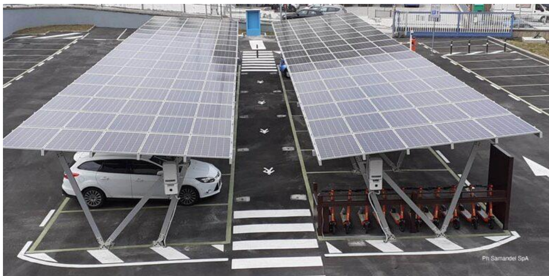
Obrázek 16 Ilustrační foto zastřešeného parkoviště - carpotu (zdroj: www.futurasun.com )
