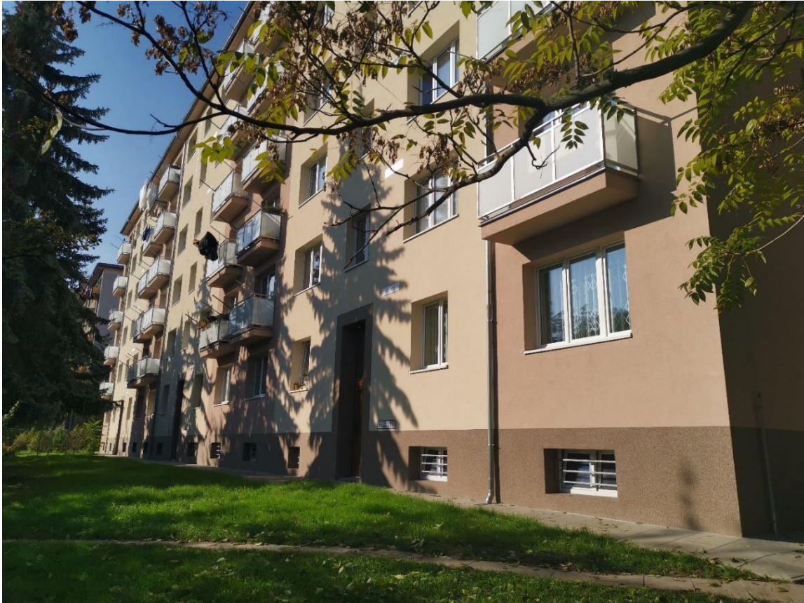
Obrázek: Vzhled budovy po zateplení
