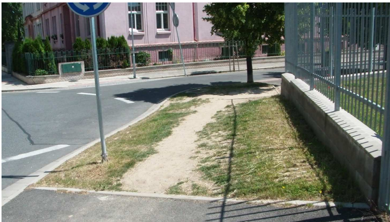
Obrázek 90: Důsledek nevhodného vedení pěší dopravy mezi ulicemi Pionýrů a Dr. Horákové
