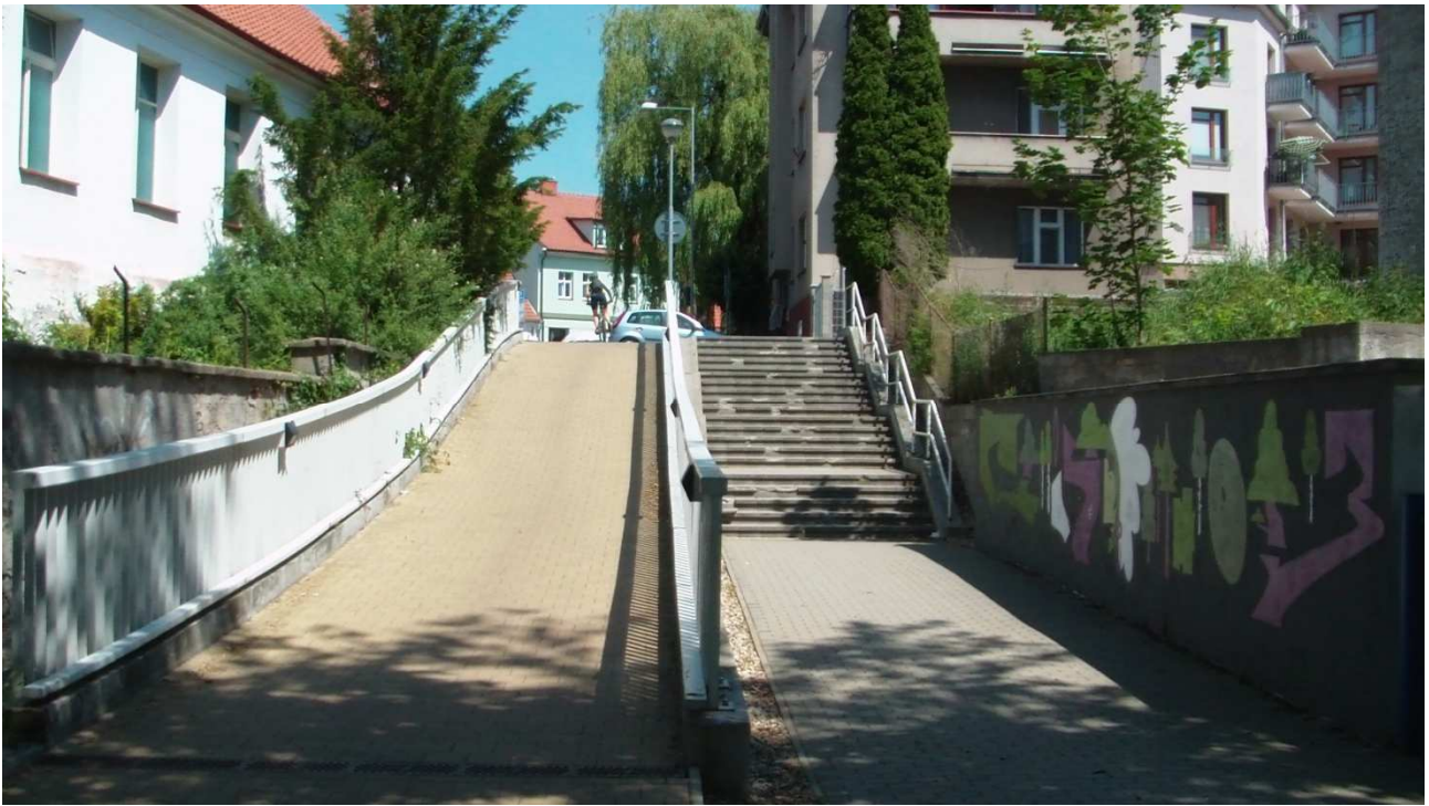
Obrázek 91: Absence bezbariérového vedení pěší dopravy (vlevo stezka pro cyklisty), ul. Říční
