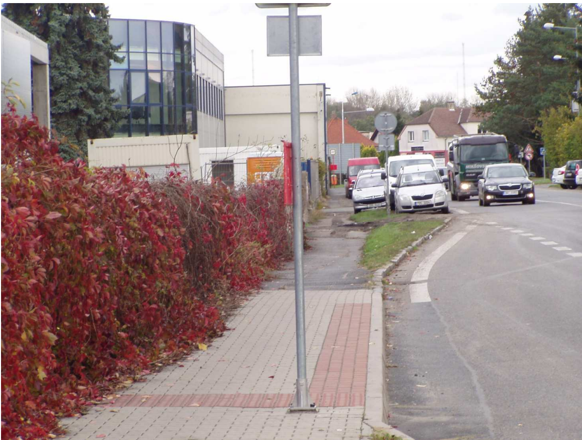
Obrázek 92: Nevhodný stav pěší komunikace pro přístup k zastávce Poděbrady, Oáza
