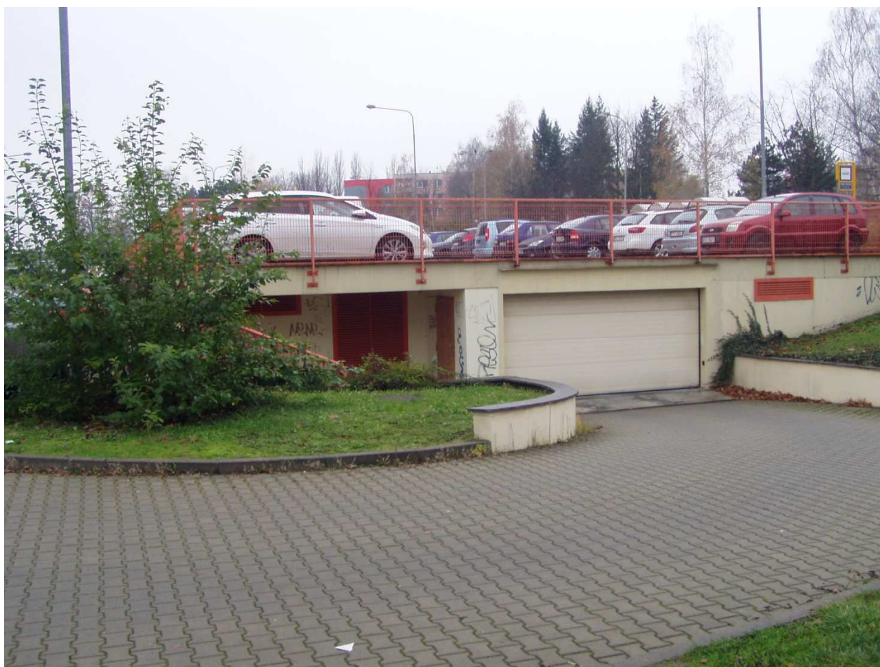
Obrázek 61: Dvoupodlažní napůl zapuštěná garáž s celkovou kapacitou 50 stání, Ostrava, ulice B. Nikodéma
