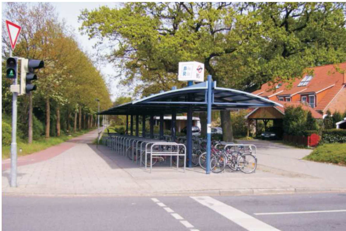
Obrázek 68: Zahraniční příklad úschovny kol u dopravního terminálu s kapacitou 100 kol, náklady zhruba 1 mil. Kč
