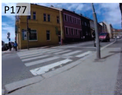
Částečně bezbariérový přechod pro chodce v Budějovické ulici /chybí signální pásy, chybí varovné pásy, malé nerovnosti, příčný sklon 4-5 %/.
