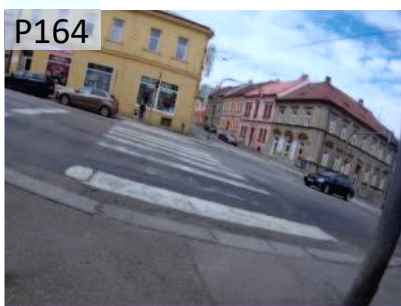
Bariérový přechod pro chodce v Budějovické ulici /chybí signální a varovné pásy, chybí vodící pás, nadměrná délka přecházení bez světelné signalizace či ochranného ostrůvku/.
