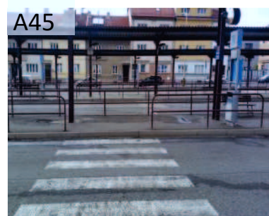
Bariérová zastávka č. 14 na autobusovém nádraží /bariérový přístup na nástupiště (nesnížený obrubník přechodu pro chodce), varovné a signální pásy pro osoby s omezenou schopností orientace/.
