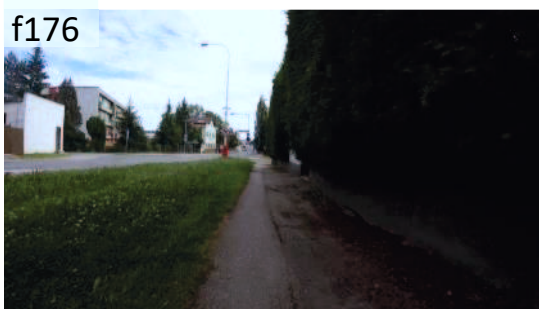
Bariérový chodník v Zavadilské ulici /nerovnosti, vzrostlá zeleň zasahující do prostoru pohybu chodců/.
