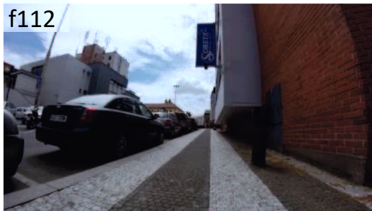
Částečně bezbariérový úsek chodníku ve Vančurově ulici /podélný sklon 6 %, kontrastně neoznačené bariéry podél vodící linie - vysazená stěna do prostoru pohybu chodců je bariérou pro osoby se zrakovým omezením (resp. pro osoby nevidomé)/.
