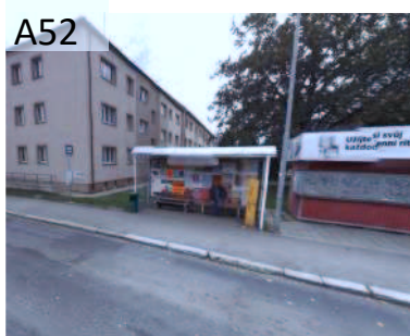
Bariérová zastávka „Písecké rozcestí“ na náměstí Prokopa Velikého /zastávkový obrubník dosahuje výšky jen 5 cm, chybí varovný a signální pás pro osoby s omezenou schopností orientace/.
