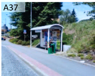
Bezbariérová zastávka „Černé mosty“ /zastávkový obrubník dosahuje výšky 16 cm - což je dle vyhlášky č. 398/2009 Sb. dostačující pro změny dokončených staveb/.
