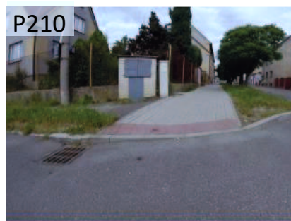
Částečně bezbariérové místo pro přecházení ve Vožické ulici /chybí signální pásy, nedostatečně snížený obrubník, malé nerovnosti/.
