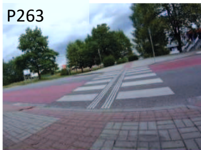
Bezbariérový přechod pro chodce v ulici Václava Soumara.
