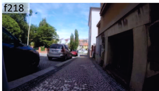
Bariérový úsek chodníku v Husově ulici /podélný sklon 11 % v délce nad 900 cm/.
