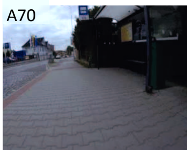
Částečně bezbariérová zastávka „TAPA“ v ulici Chýnovská /zastávkový obrubník dosahuje výšky jen 14 cm/.
