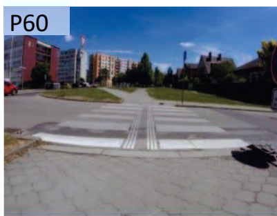
Částečně bezbariérový přechod pro chodce v ulici Jana z Ústí /chybí signální pásy, chybí varovné pásy - pro osoby se zrakovým omezením/.
