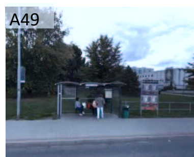
Částečně bezbariérová zastávka „Nemocnice“ v ulici Kpt. Jaroše /chybí signální pás, staničník zastávky umístěn mimo nástupiště v zatravněné ploše/.
