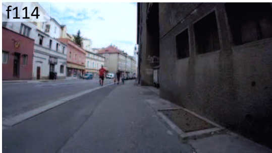
Částečně bezbariérový úsek v Budějovické ulici /malé nerovnosti, bariéry podél vodící linie (stěny budovy)/.
