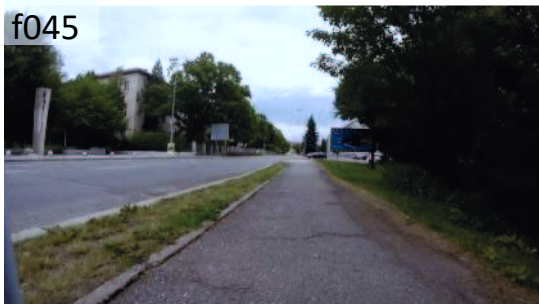
Částečně bezbariérový chodník v ulici Kpt. Jaroše /malé nerovnosti, nezřetelná vodící linie/.
