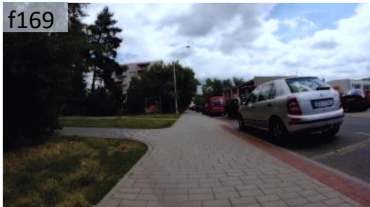
Bezbariérový chodník v Sokolovské ulici /správně řešený varovný pás u obruby snížené do výšky 8 cm nad vozovkou/.
