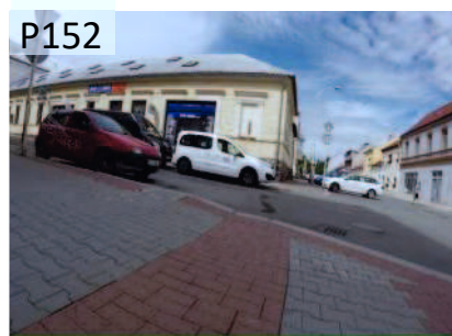
Bariérové místo pro přecházení v Kollárově ulici /malé nerovnosti, významný příčný sklon/.
