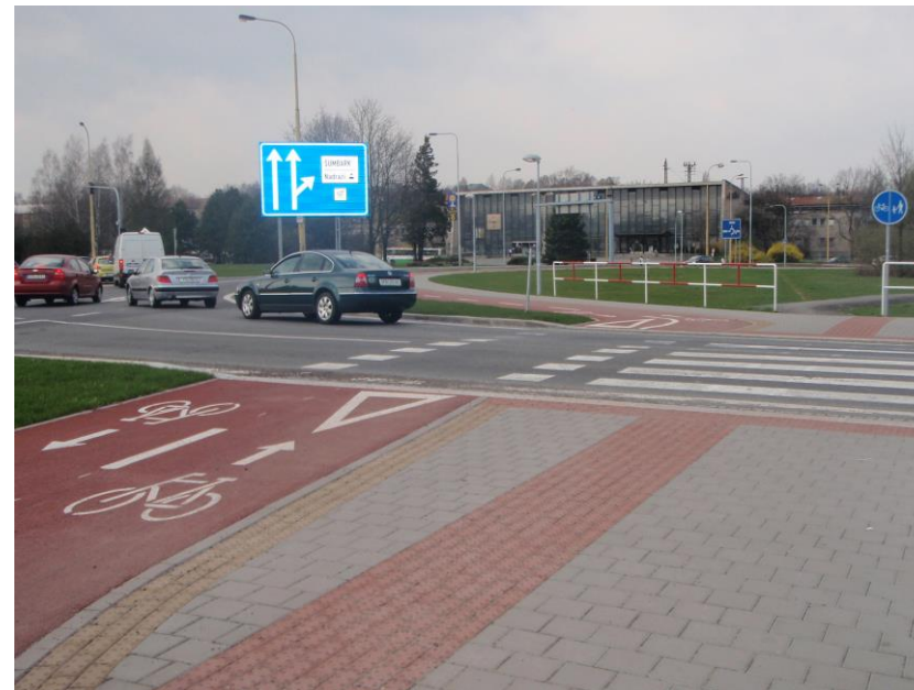
Řešení přejezdu pro cyklisty s navazující cyklostezkou.
