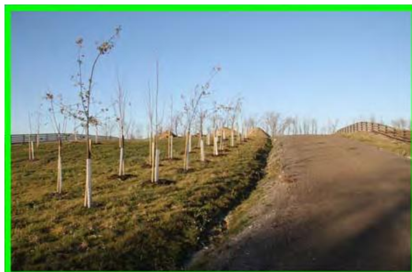
Ukázka dobře vyřešené rekreační vazby – překonání rychlostní komunikace s využitím biomostu (Praha, Vysočanská radiála).
