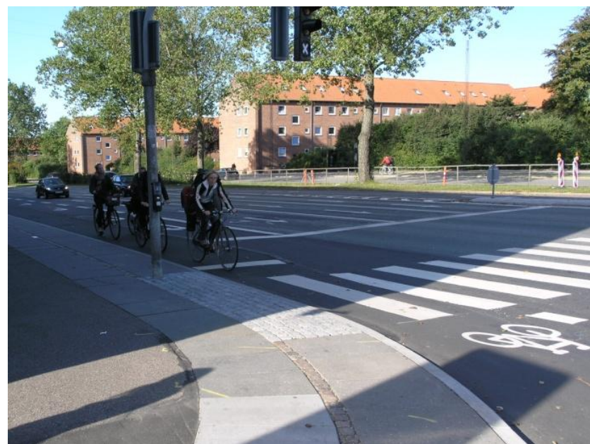
Ilustrační příklad: Aarhus (Dánsko), Vestre Ringgade – jednosměrné vedení po pravé straně nevylučuje fyzické oddělení od motorové dopravy a zároveň umožňuje zachování plynulosti srovnatelné s pohybem ve vozovce
