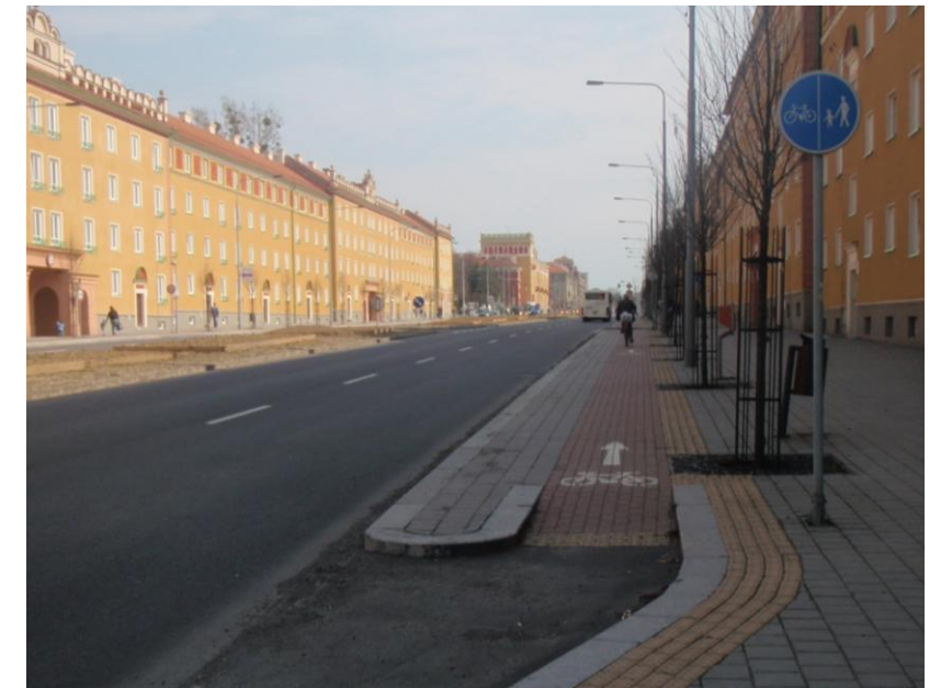
Ukázka návaznosti cyklostezky v přidruženém prostoru na komunikaci s velkou intenzitou cyklistů, kde je oddělení od chodců prostřednictvím vysázených stromů.
