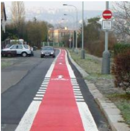
Foto 9, 10 a 11 : ilustrační foto vyhrazeného jízdního pruhu pro cyklisty v protisměru jednosměrné komunikace (ul. Na Vrstvách, Praha 4 - autoři projektu Ing. Květoslav Syrový a Tomáš Prousek)
