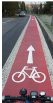
Foto 9, 10 a 11 : ilustrační foto vyhrazeného jízdního pruhu pro cyklisty v protisměru jednosměrné komunikace (ul. Na Vrstvách, Praha 4 - autoři projektu Ing. Květoslav Syrový a Tomáš Prousek)
