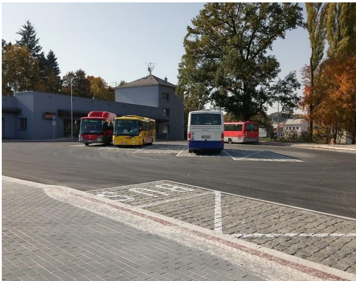
Obrázek 17 Foto: Rekonstruovaný autobusový terminál u vlakového nádraží v Bílovci
