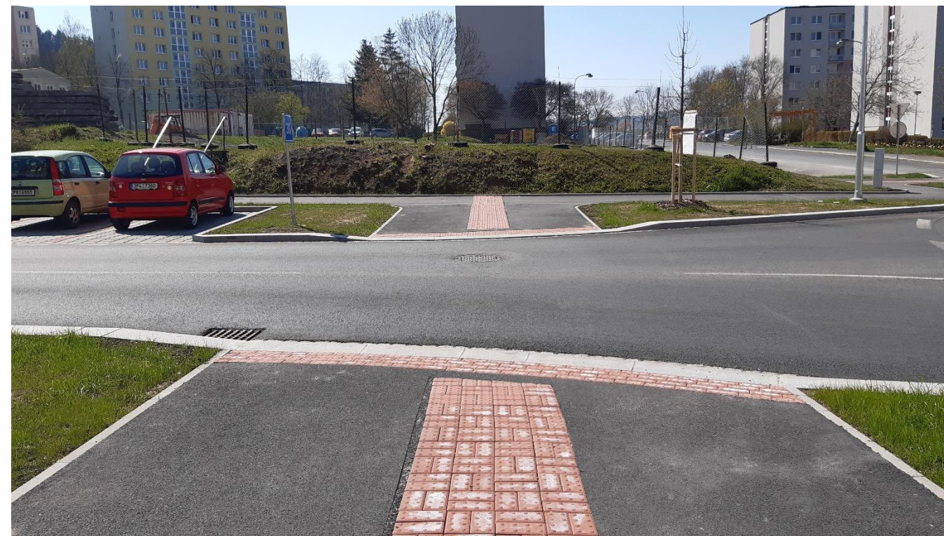
Obrázek 62 Ukázka provedení signálního pásu v místě pro přecházení a snížená podsádka na +2 cm (ul. Podhůrecká, 2021)
