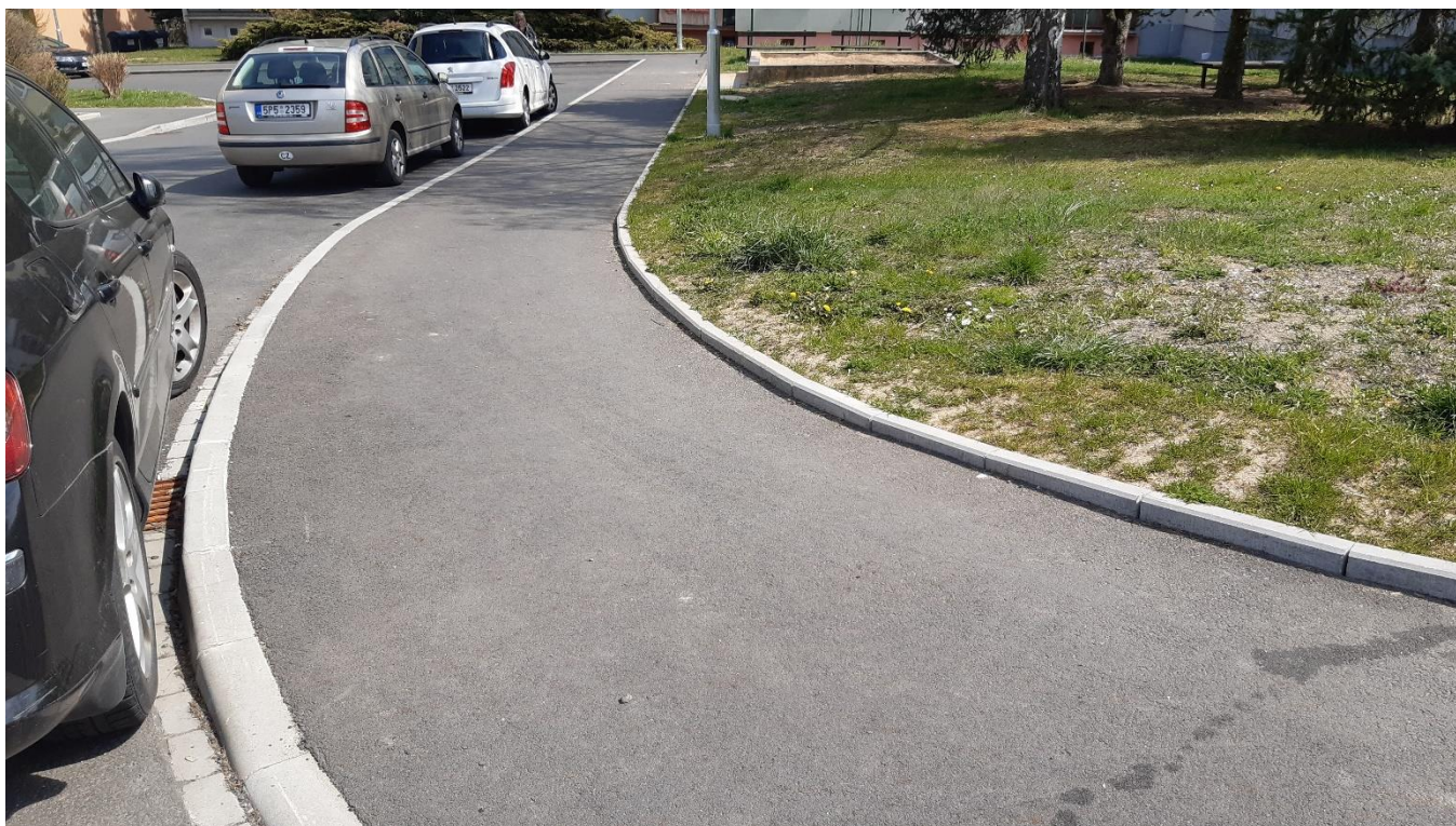
Obrázek 63 Ukázka vodící linie – obrubník s podsádkou +6 cm (ul. Zahradní, 2021)
