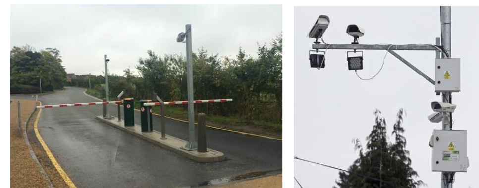
Obrázek 23 Návrh rozmístění detekce RZ kamerovým systémem
