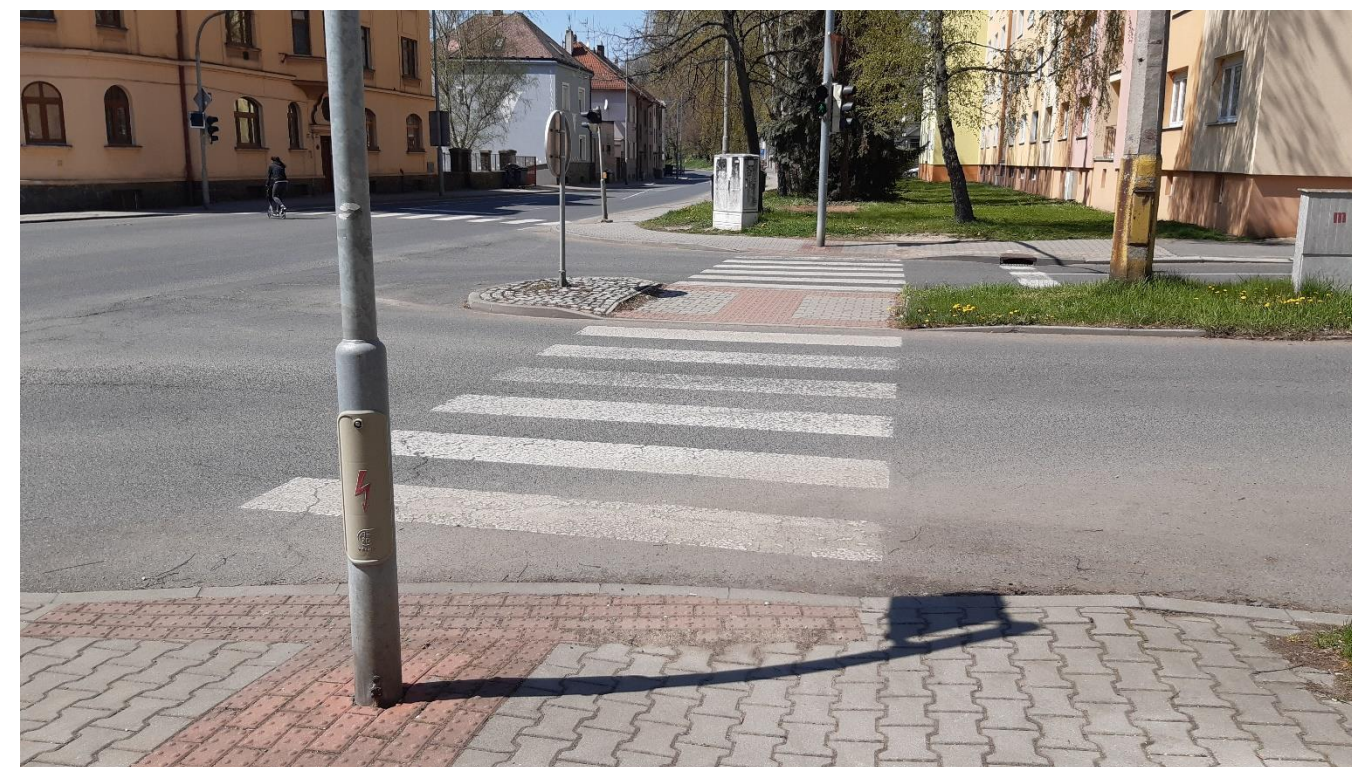
Obrázek 65 Ukázka zkrácení délky přechodu pro chodce středním dělicím ostrůvkem/pásem (ul. Dukelská, 2021)
