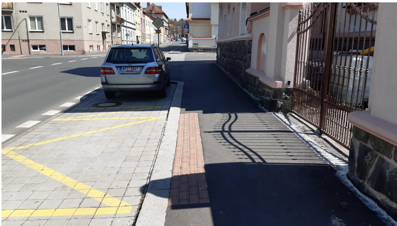
Obrázek 61 Ukázka správného provedení varovného pásu v místě vjezdu (ul. Kollárova, 2021)
