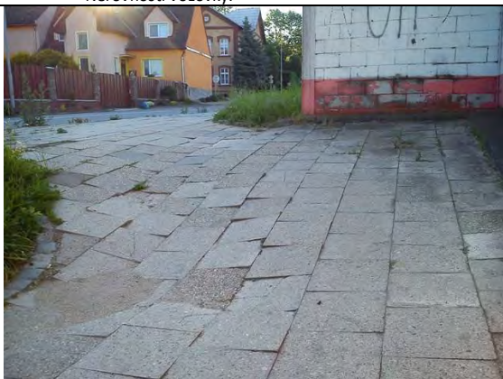
J5 Chodník v ulici Pod Valy (proti ČSPHM) Bariérový Nerovnosti povrchu.
