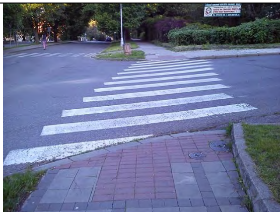
Z4p Přechod přes U Stadionu směr Tovární Bariérový Neúplný signální pás. Nenormová délka přechodu.
