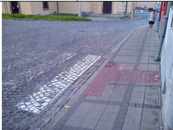
O6p Přechod přes Komenského směr Masarykovo náměstí Bezbariérový s výhradou Varovný pás nedostatečné délky. Porušené vodorovné dopravní značení.
