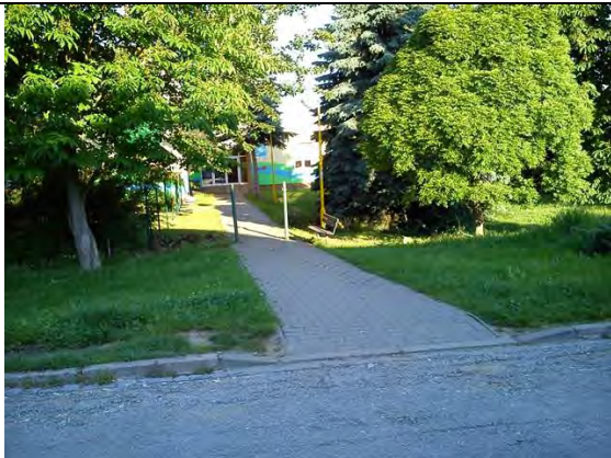
J1 Přístup do školky Olšava Bariérový Chybí varovný a signální pás. Zúžený profil chodníku. Nerovnosti vozovky.
