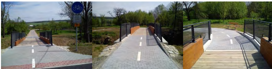
Obr.43. Mostky na novém vedení cyklotrasy I. 5049
