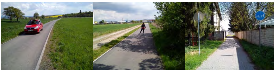
Obr.41. Komunikace napojující Havšcké stráně komunikace mezi Cihlářskou a Vazovou, propojka k Tesco
