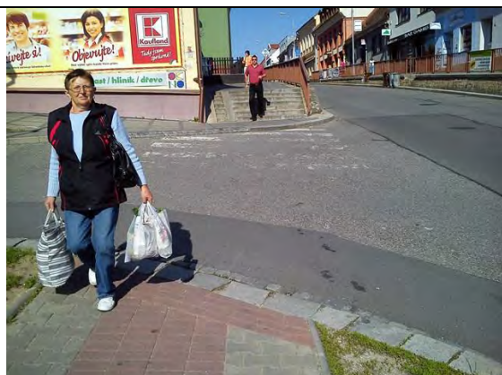
V3p Přečhod přes U Fortny Bariérový Nedostatečně snížené obruby. Nezřetelné vodorovné dopravní značení.
