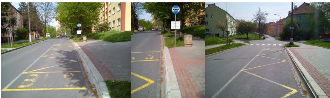
Obr.60. Rekonstruovaná zastávka sídl., novinový stánek
