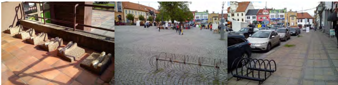
Obr.47. Příklady cyklistických stojanů neumožňujících zamknutí rámu jízdního kola (zleva: Dům kultury, Masarykovo náměstí)
