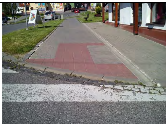
V4p Přečhod přes Pořadí směř Moravská. Bariérový Nedostatečně snížená obruba.
