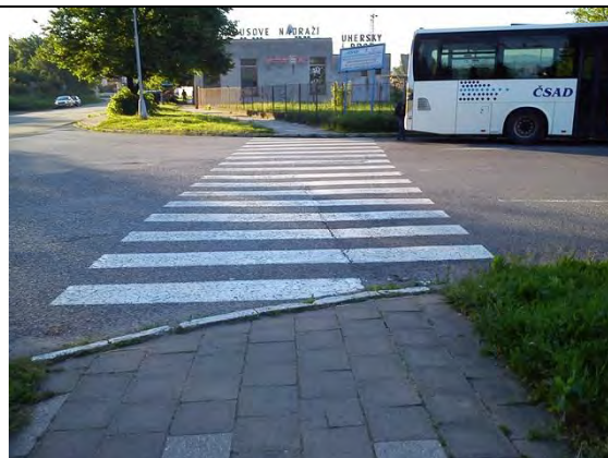
J6p Přechod přes výjezd z autobusového nádraží Bariérový Nenormová délka přechodu. Chybí veškeré hmatné úpravy.
