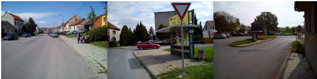
Obr.57. Stavebně technicky zastaralé provedení prostoru zastávek (Havšce u ěkolky, VII'novská, Lapa')
