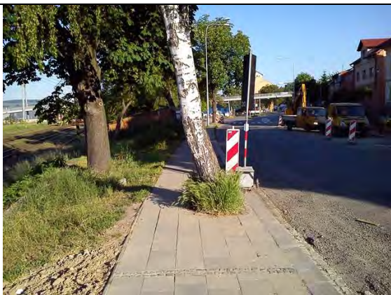
P1 Chodník ulice Pod Valy směr vlaková stanice Bariérový Nedostatečná šíře chodníku.
