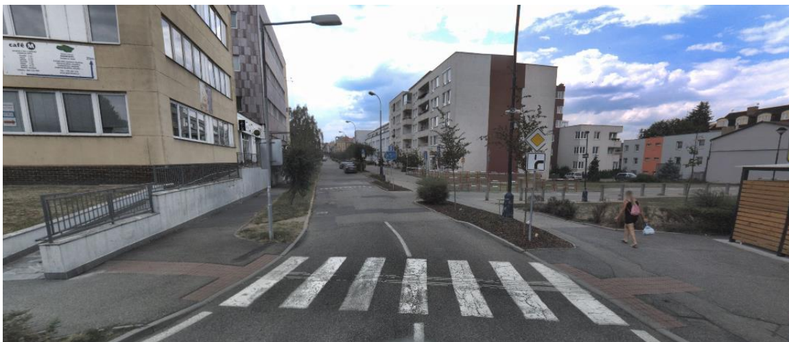
Obrázek 117 Příklad správného a nesprávného užití signálního pásu u přechodu pro chodce, Jiráskova ulice u OK. Vpravo není signální pás dotažen k přirozené vodící linii, nevidomí se nedozví o přechodu pro chodce.
