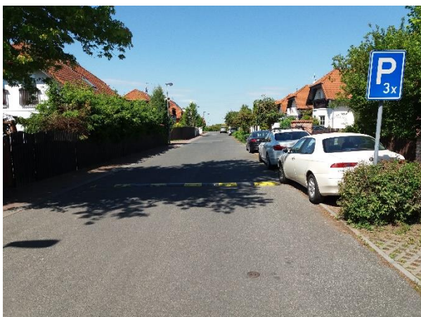
Obrázek 19 a 20: vlevo montovaný příčný práh uprostřed obytné zóny, vpravo stavebně upravený nájezd do obytné zóny
