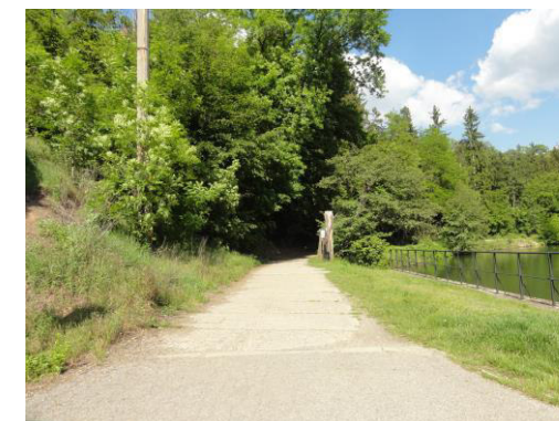
Povrch z železo - betonových panelů
