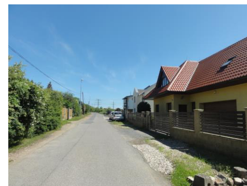
Asfaltový povrch s lehkými poruchami
