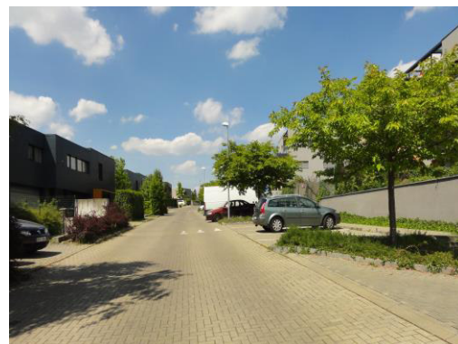
Povrch z betonové dlažby bez závad
