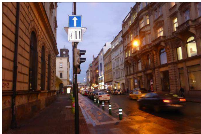
Obrázek č. 9 – použití balisetů u vyústění protisměrného cyklistického pruhu v jednosměrné komunikaci do křižovatky – Praha
