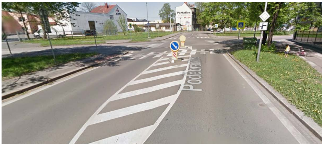
Obrázek 41 – Příklad správného řešení přechodu v ulici Poděbradova v Ostravě
