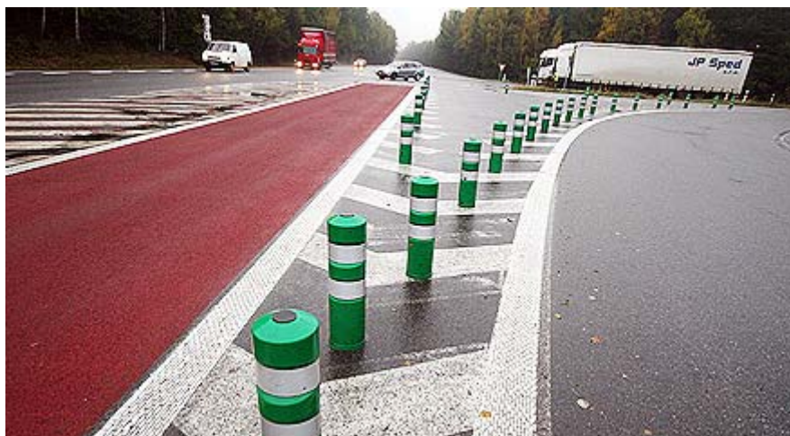
Obr. 25 - Částečná kanalizace křižovatky pomocí baliset na větvích MÚK v km 112 na dálnici D1 (zdroj: http://www.jihlavske-listy.cz )
