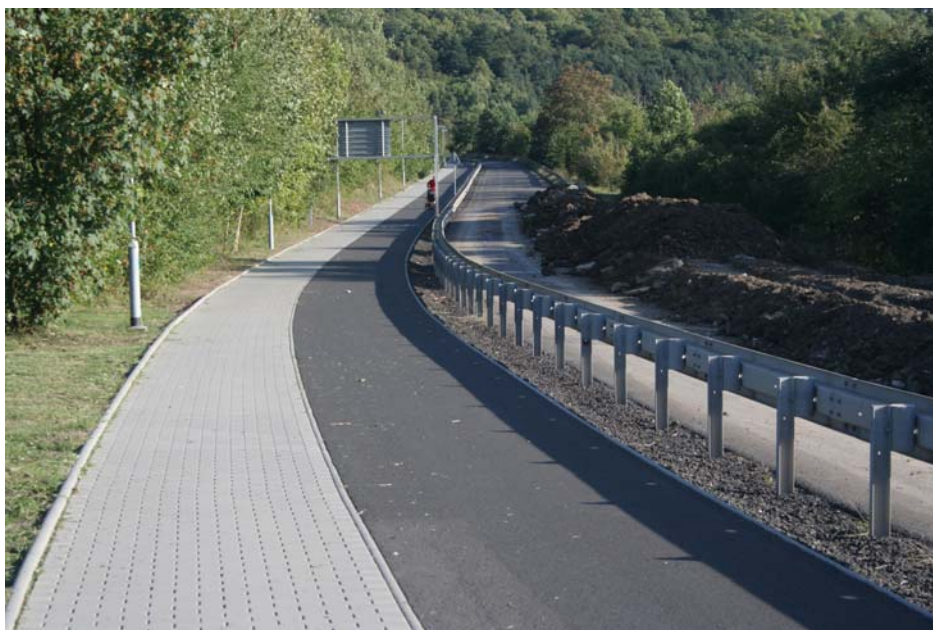
Obr. 19 - Vedení silnice II/568 a stezky pro pěší a cyklisty na sdruženém tělese v Kadani
