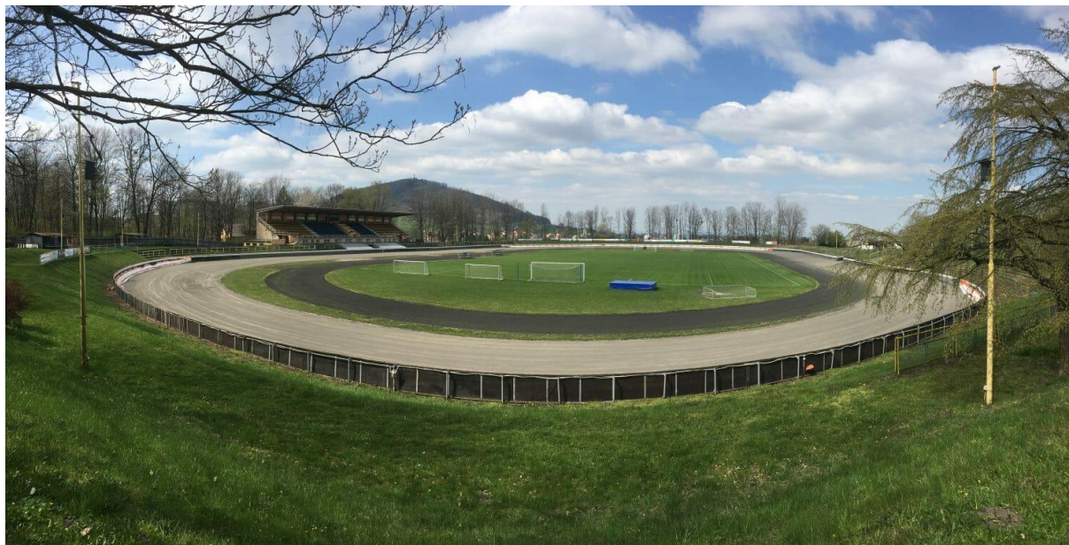
Obrázek 2: Letní stadion – stav před rekonstrukcí.
