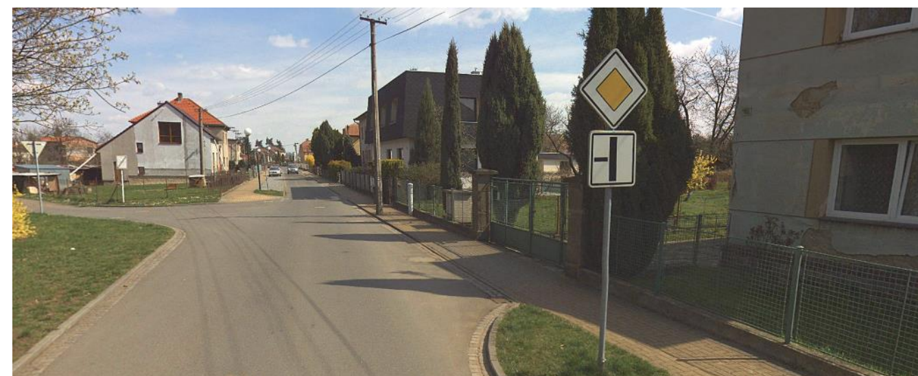
Obousměrný provoz na 5,25m široké vozovce s jednostranným dlážděným parkovacím pruhem.
