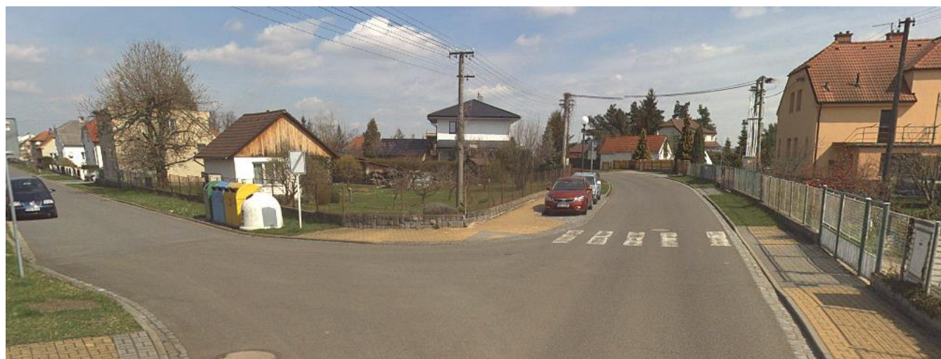
Obousměrný provoz na 5,25m široké vozovce s jednostranným dlážděným parkovacím pruhem.
