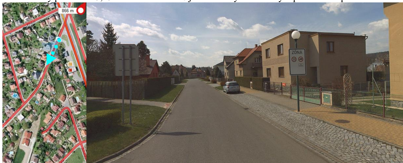
Nájezd do dvoupruhového obousměrného úseku s 5,25m širokou vozovkou s jednostranným dlážděným parkovacím pruhem.
