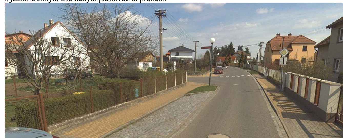
Koncový úsek jednopruhového obousměrného úseku s 3,5m širokou vozovkou délky cca 120m s jednostranným dlážděným parkovacím pruhem
