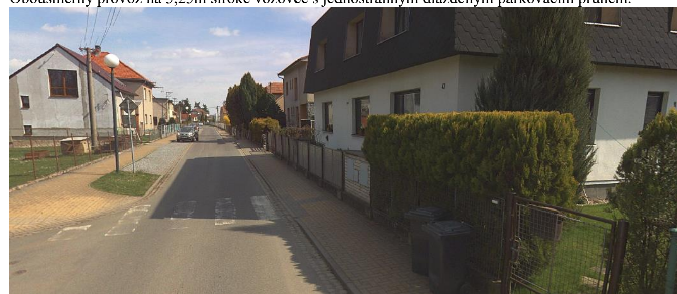
Nájezd do jednopruhového obousměrného úseku s 3,5m širokou vozovkou délky cca 120m s jednostranným dlážděným parkovacím pruhem.
