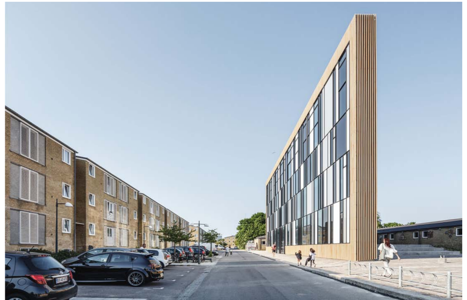
reference: knihovna a kulturní dům Tingbjerg, návrh: COBE, příklad novostavby v rámci staršího sídliště, která do území vnáší společenskou náplň
