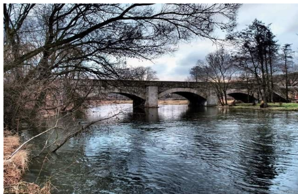
silnice I/22 – most přes Úhlavu v Beňovech
