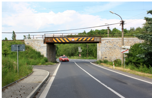
podjezd silnice I/27 pod trať v Dehtíně (pohled od jihu)
