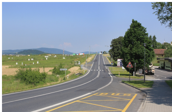
silnice I/22 v Soběticích (pohled od jihovýchodu)
