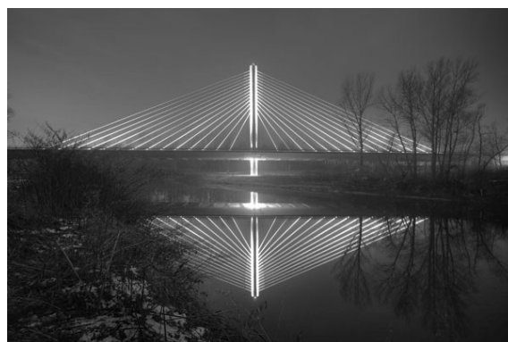
Obr. 2 – Most přes Odru na D47 ( www.asb-portal.cz )
