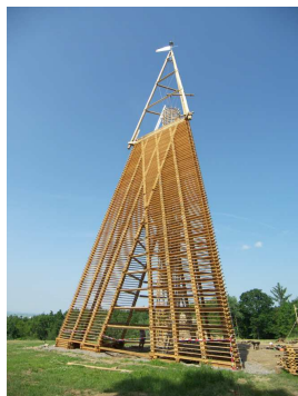
Rozhledna Bára I. po dokončení
