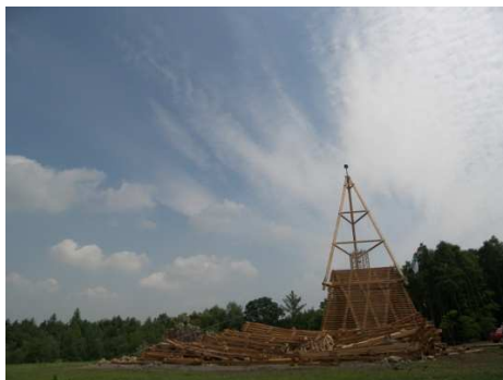
Škody způsobené tornádem
