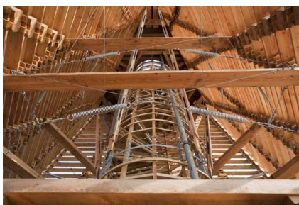
Některé zpevňující prvky rozhledny (ukotvení)
