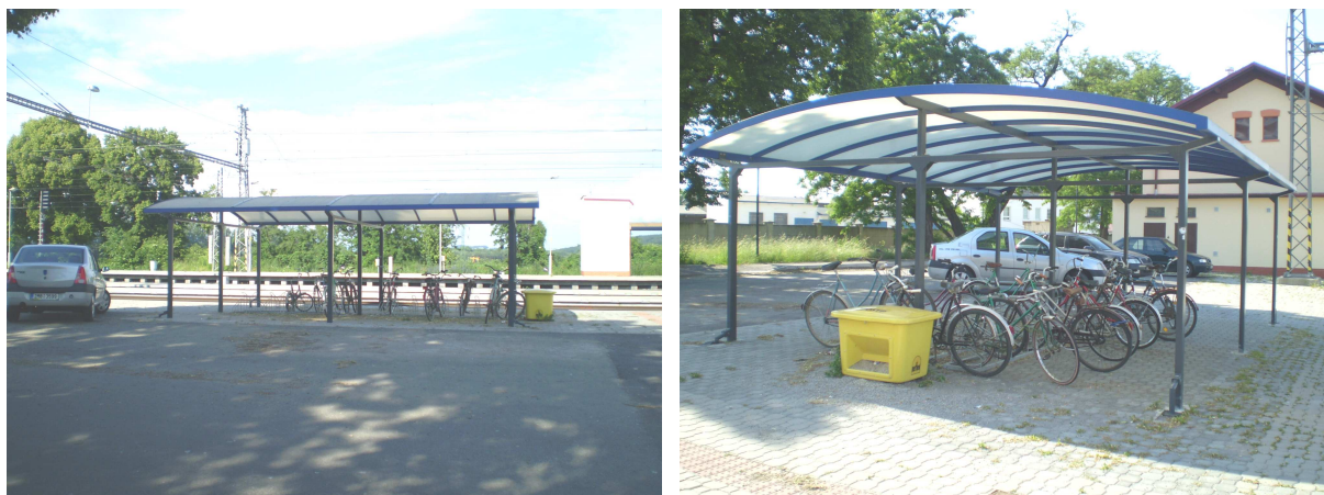
Mohelnice – Olomoucký kraj v rámci rekonstrukce stanice
