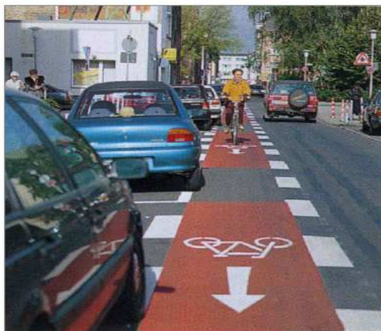
Obr. 1 - Optické oddělení cyklistického pruhu vedeného v protisměru vůči motorové dopravě v hlavním dopravním prostoru (Krefeld, SR Německo)
