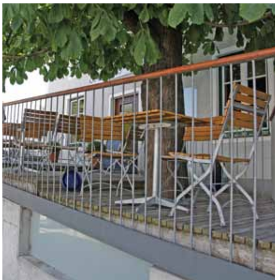
Subtilní zábradlí předzahrádky, stávající jírovec je umístěn v dřevěné podestě, jedná se o stavbu Obr. A047 / Rakousko, Drosendorf, Mohnkaffeehaus
