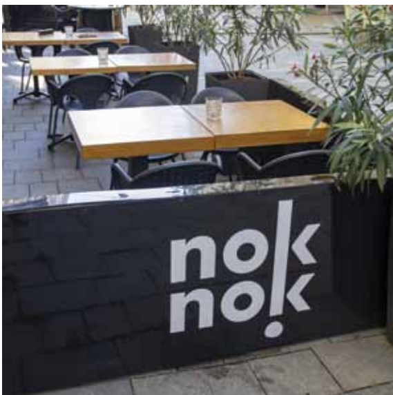
Ohrazení do výšky stolů, neprůhledná výplň je přípustná v rozsahu jednoho pole pro označení provozovny Obr. A055 / Brno, ul. Zámečnická, NOK NOK
