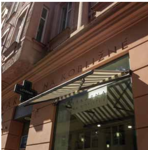
Markýza s pruhovanou látkou, provedení bez boxu v šířce výkladce nezatěžuje fasádu přidáním prvků Obr. B101 | Brno
