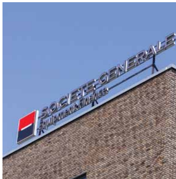
Firemní označení na střeše firemního sídla, provedení v šedé barvě je v souladu s oplechováním atiky Obr. B128 / Brno
