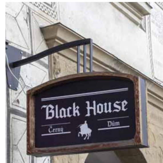
Vývěsní štít na památkově chráněném objektu, vhodné provedení z tradičních materiálů a v tlumené barevnosti Obr. B059 | Třebíč
