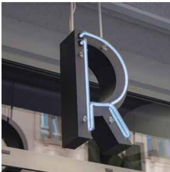
Detail neonového nápisu, klíčové je kvalitní řemeslné provedení a skrytí přívodních kabelů Obr. B164 / Brno
