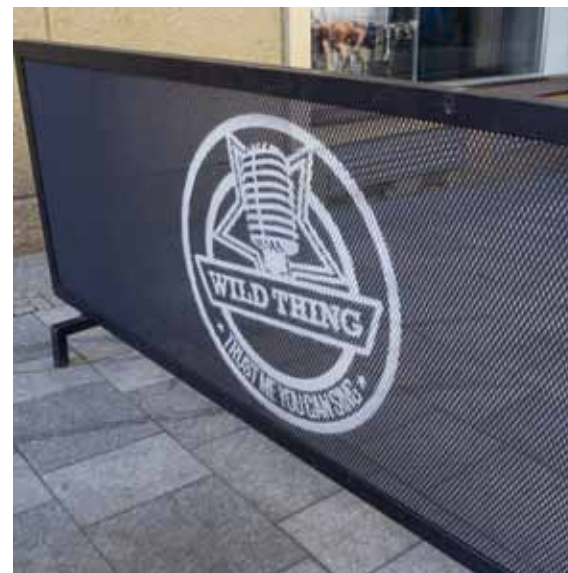
Mobilní ohrazení s výplní z tahokovu, označení provozovny zabírá maximálně 1/3 pole, preferuje se větší průhlednost Obr. A057 / Brno, ul. Zámečnická, bar WILD THING
