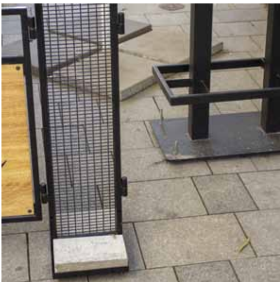
Kovové ohrazení s průhlednou výplní stabilizované kamennými deskami, vhodné řešení, pokud je ohrazení nezbytné Obr. A052 / Brno
