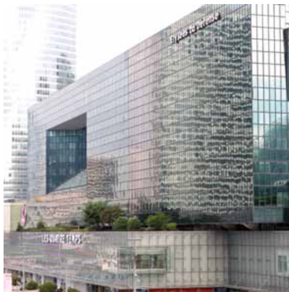
Označení obchodního domu ve vyšších podlažích v přijatelném decentním provedení Obr. B032 / Francie, Paříž, obchodní dům Elysées La Défense
