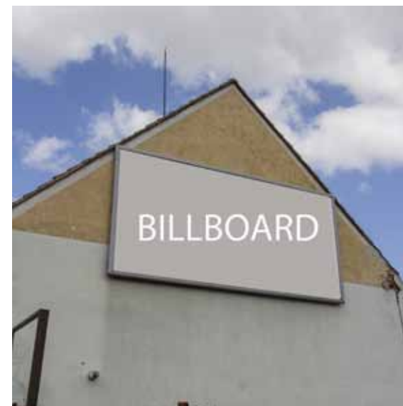
Billboardy jsou v městském prostředí nežádoucí, zvláště pokud jsou umístěny na budovách Obr. B152 | Třebíč
