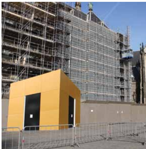
Sítě na lešení a neprůhledné oplocení staveniště bez reklam, architektonicky ztvárněný vstup na staveniště Obr. B171 | Nizozemí, Amsterdam
