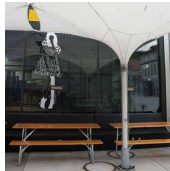
Netradiční forma slunečníku ve tvaru trychtýře v areálu vniklém konverzí historických budov, vyžaduje individuální posouzení Obr. A037 / Rakousko, Krems, Donau Universität Krems
