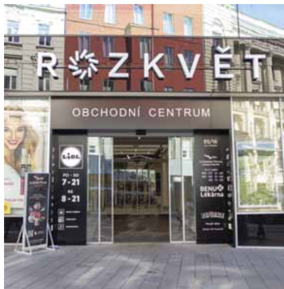
Obchodní dům s názvem umístěným nad dveřmi a označení provozoven umístěné v ostěni Obr. B106 | Brno
