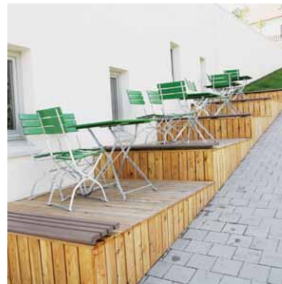
Vhodný typ podesty bez zábradlí ve svažitém terénu, na chodníku z betonové dlažby Obr. A042 / Pavlov, Galerie Venuše Pálava
