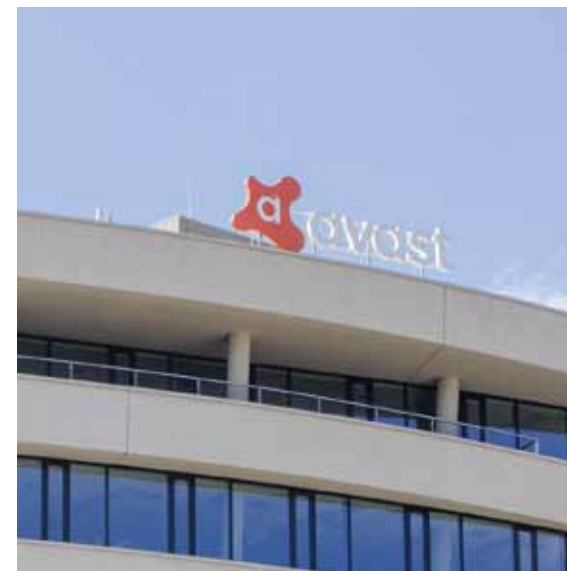
Firemní označení na střeše, barevnost odpovídá barvě fasády a firemním barvám, měřítkem ladí s prvky fasády Obr. B127 / Brno
