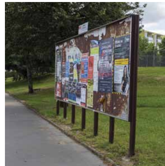
Velkoformátová plakátovací plocha, zastaralá konstrukce a neudržovaný stav nepřináší estetickou kvalitu do prostoru Obr. B143 | Třebíč
