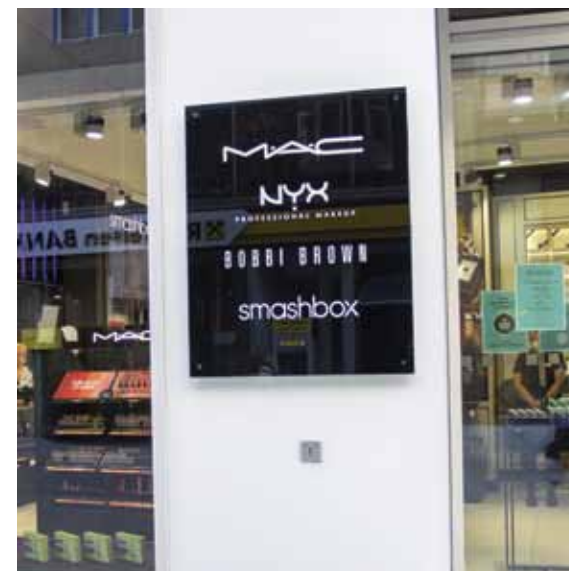
Nabídková tabule ze skla umístěná v ploše proskleného výkladce, vhodné provedení pouze u soudobých budov Obr. B095 | Brno
