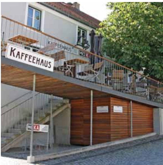
Předzahrádka jako stupňovitá terasa postavená ve stopě historického zápraží, jedná se o stavbu povolenou ve stav. řízení Obr. A040 / Rakousko, Drosendorf, Mohnkaffeehaus
