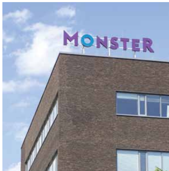
Firemní označení na střeše, vhodné provedení nápisu z jednotlivých písmen Obr. B126 / Brno
