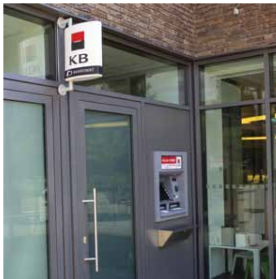
Bankomat obvodovém plášti budovy, výstrč malých rozměrů a bankomat bez nadbytečných polepů a nápisů Obr. B124 | Brno
