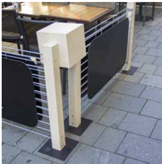
Subtilní ohrazení předzahrádky do úrovně výšky stolů, sloupky jsou preferovány kovové Obr. A053 / Brno
