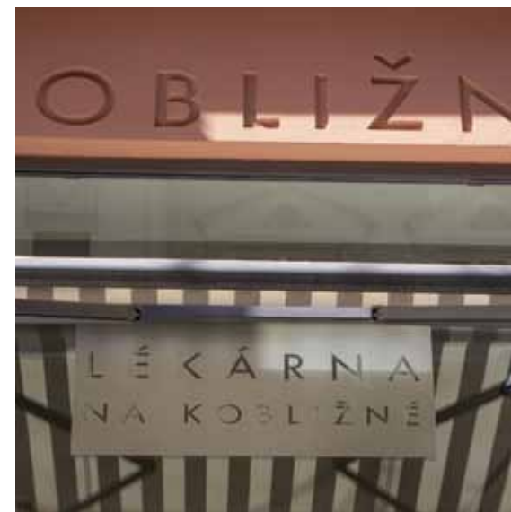
Polep výkladce imitující pískované sklo, označení provozovny je provedeno plastickým nápisem v omlítce Obr. B052 / Brno
