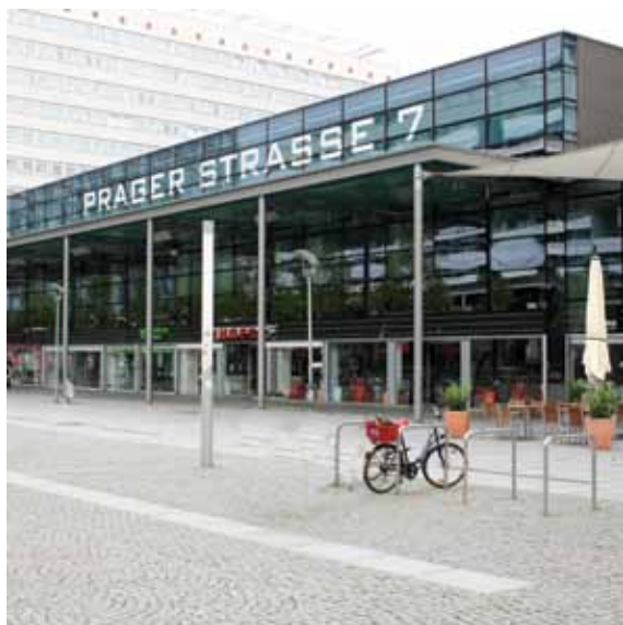
Označení budovy ve vyšších podlažích, přípustné řešení v případě obchodního domu, kultivované provedení Obr. B031 / Německo, Drážďany
