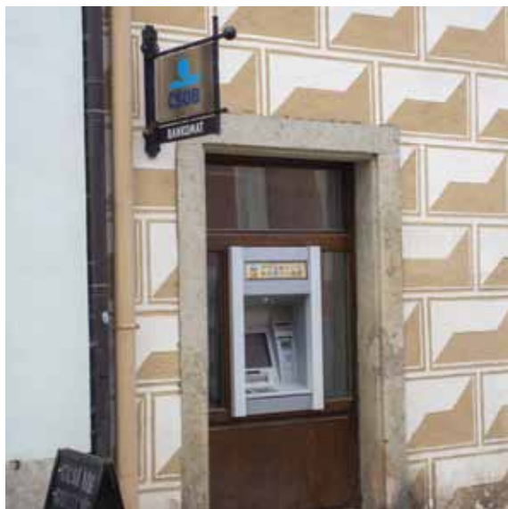
Bankomat označený historizující výstrčí minimálních rozměrů, provedení odpovídá hodnotě budovy Obr. B123 | Telč
