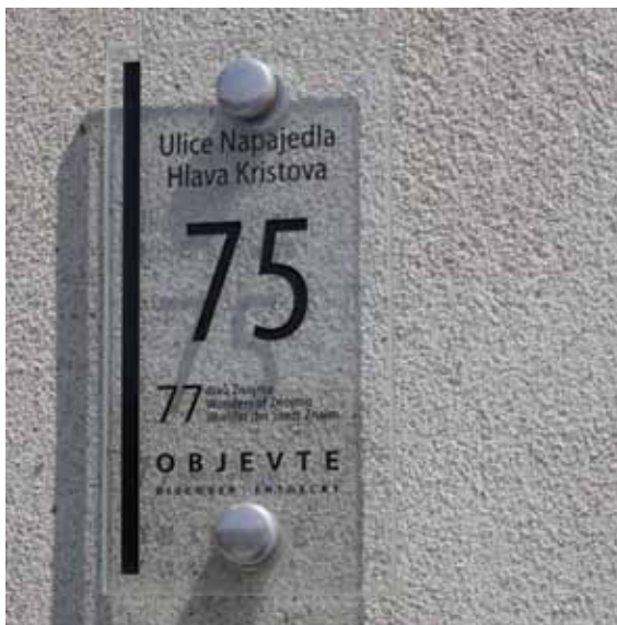
Skleněnou desku kotvenou distančními šrouby lze užít i pro označení provozovny v historickém objektu Obr. B115 / Znojmo
