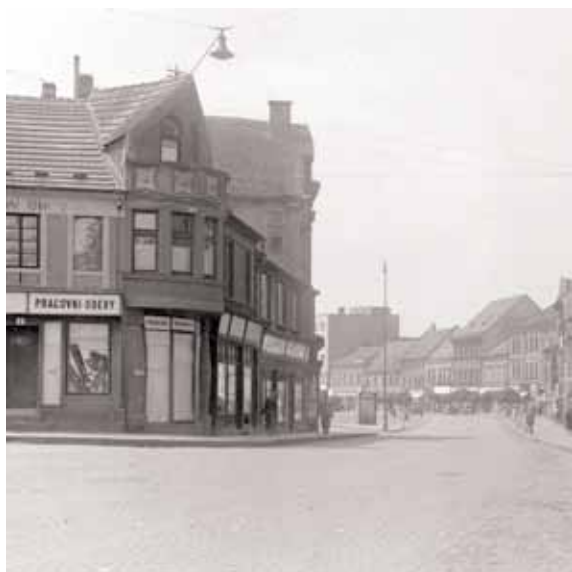
Provozovny v Jejkovské (Brněnské) bráně, která byla stržena roku 1898, kdy se třebíčský rynek zbavoval pevného sevření hradbami Obr. B011 | Archiv Muzea Vysočiny Třebíč
