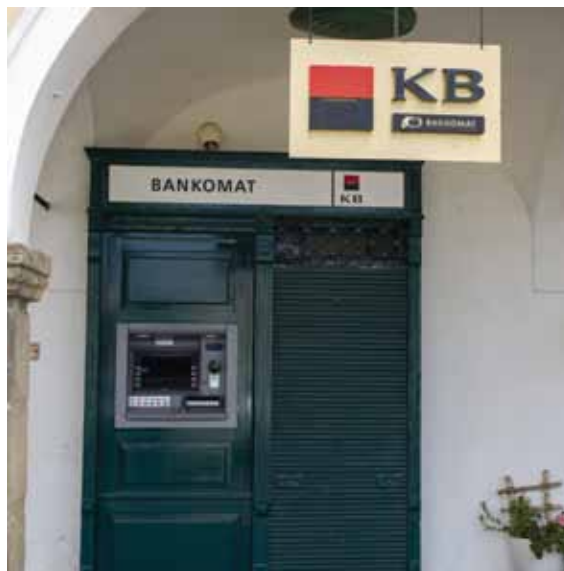
Bankomat v podloubí označený vývěsním štítem, kvalitní historizující řemeslné provedení Obr. B121 | Telč
