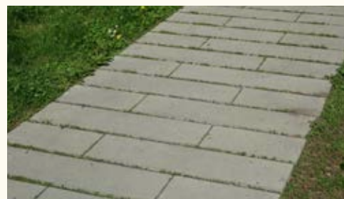
Chodník z betonových obrub na ležato Brno - vnitroblok Křídlovická
