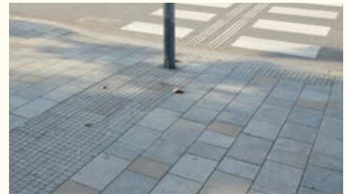
Mělce snížená nástupní část přechodu Brno - ulice Joštova
