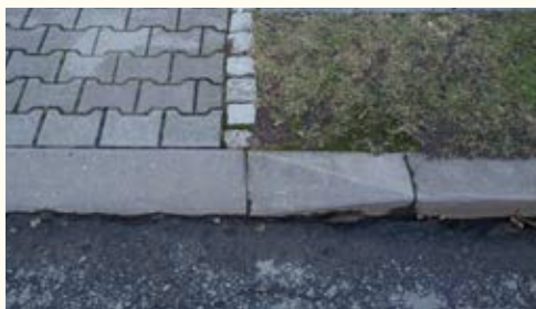
Detail tvarovky sklopeného obrubníku Krnov - ulice Pionýrů
