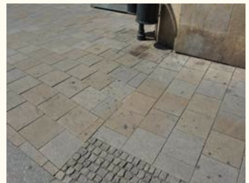
Při křížení dvou ulic pokračuje k obrubníku křižovatky dlažba hlavní ulice Brno - ulice Jezuitská
