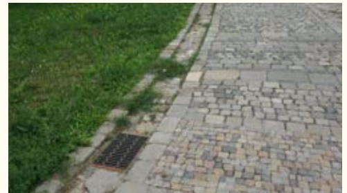
Povrchové odvádění dlážděným žlabem Brno – ulice Údolní
