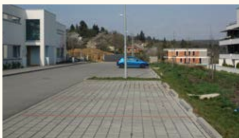
Parkovací plochy z distanční dlažby Brno - obytný soubor Panorama
