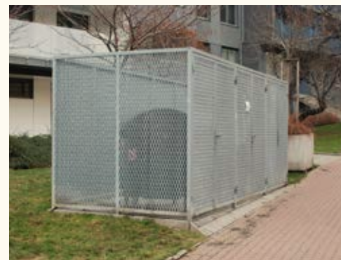
Kontejnerová zástěna z kovových roštů Praha – ulice Lupáčova
