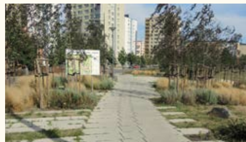
Velkoformátová dlažba volnější skladby Opava - sídliště Kateřinky
