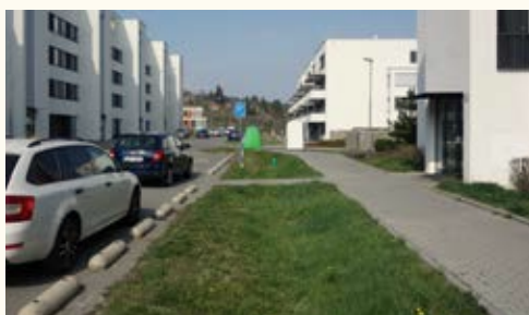
Odvodnění parkovacích ploch do zásaků Brno - obytný soubor Panorama
