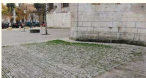
Dobře provedená travní spára na menší parkovací ploše Saint-Martin-de-Ré - Cours Bailly des Écotais
