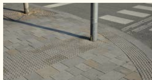
Frézované žulové pásy u přechodu pro chodce Brno - ulice Joštova
