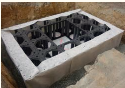
Podzemní ochrana kořenů stromu Brno – ulice Gorkého
