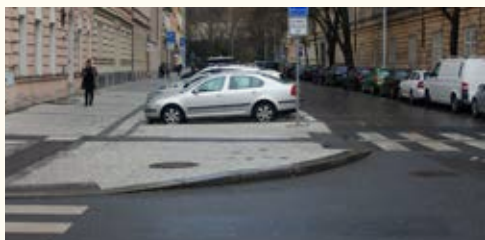
Chodník rozšířený do křižovatky dobře vymezuje prostor pro bezpečný rozhled chodce i řidiče Praha - ulice Křížkova
