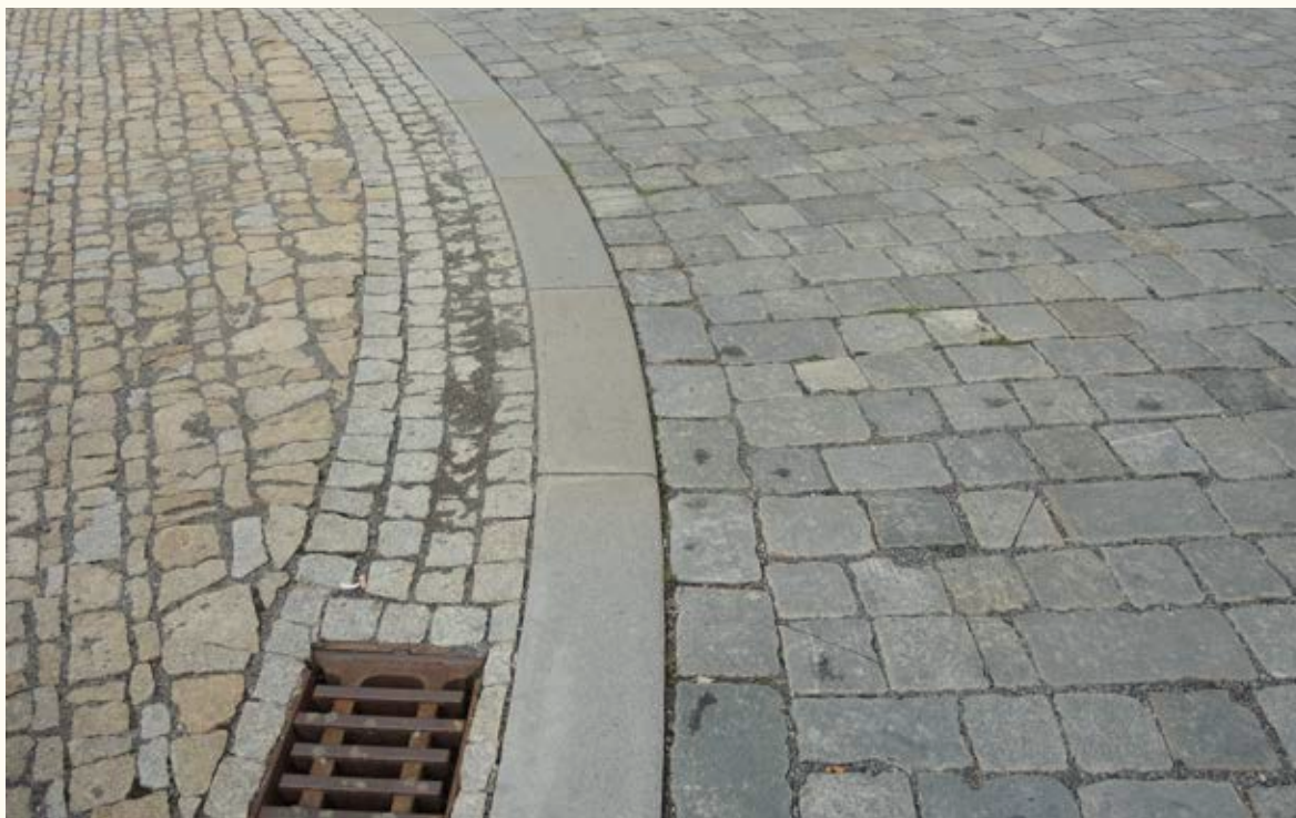
Pevné a zesílené linie pomáhají organizovat prostranství a usměrnit odvodnění jednotlivých ploch Palička - Palackého náměstí
