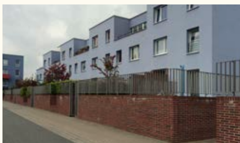
Obnova sídliště jako celku Leinefelde - Blok 5 (foto: Jannie Vinke)
