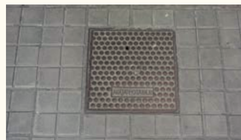
Zarovnání prvků v betonové dlažbě 20/20 Barcelona
