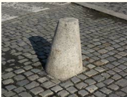
Kamenný patník zabraňující vjezdu vozidel je vhodný do historického centra Krnov – náměstí Hrdinů
