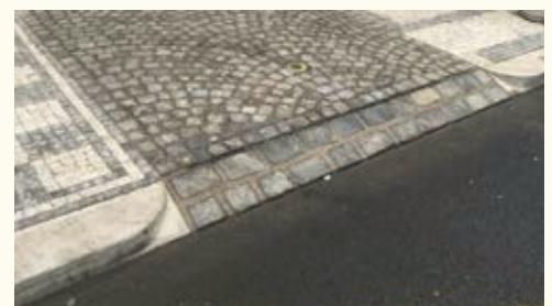
Sklopený obrubník nahrazený dlažbou Praha - ulice Husitská
