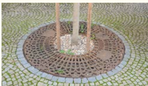
Tradiční litinová mříž Chrudim – ulice U Vodárny
