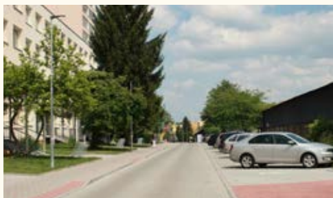
Komplexní řešení z betonových prvků Nymburk - Generála A. Sochora
