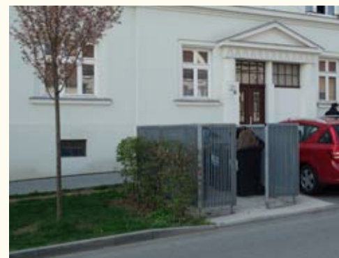
Odpadová zástěna z kovových lamel doplněná o živý plot Brno – ulice Dobrovského
