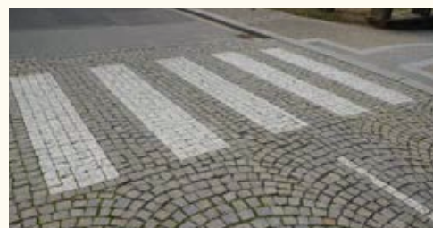
Vodorovné značení přechodů ze světlých dlažebních kostek Chrudim - ulice Hradební
