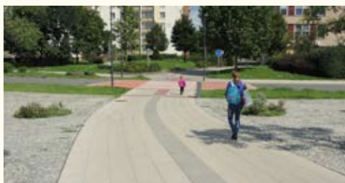
Zvýšený přechod pro chodce umožňuje plynulý pohyb Opava - nábřeží Hozovo
