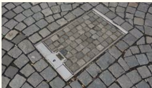
Nerezový poklop umožňující zádláždění Brno – Želý trh
