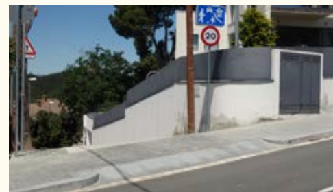
Vjezd z méně významné ulice nenarušuje kontinuitu chodníku na hlavní ulici Barcelona - ulice Carrer de les Alberes
