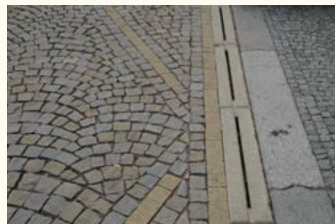
Nenápadná lineární kanalizační vpust Chrudim – ulice Hradební
