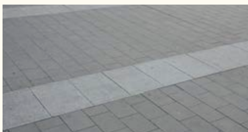
Standardní betonová dlažba bez fazetky kombinovaná s hladkou žulovou dlažbou Brno - Moravské náměstí
