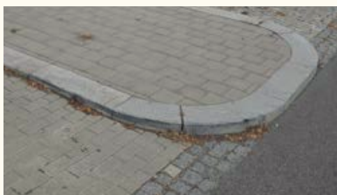
Řezaná žulová obruba 25 cm světlého odstínu v kombinaci s betonovou dlažbou Brno - ulice Botanická
