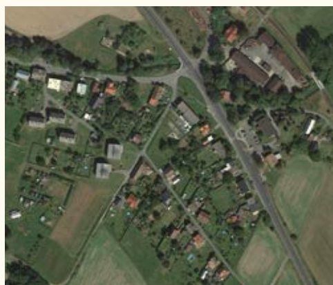
Ortofoto typické části oblasti
