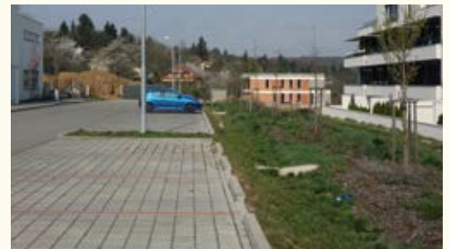
Odvodnění parkovacích ploch do zásaků Brno - obytný soubor Panorama
