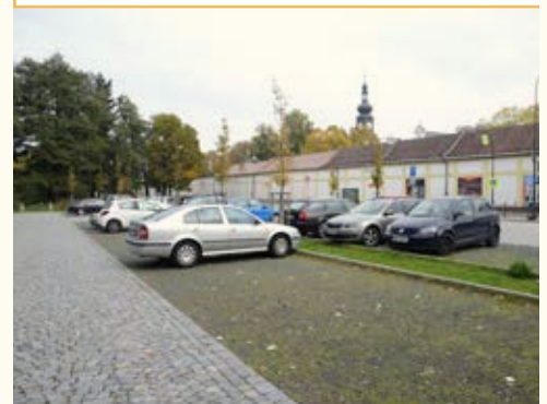
Plocha parkovišťe je citlivě členěna na menší části za použití zatravnovací dlažby. Žďár nad Sázavou - zámek
