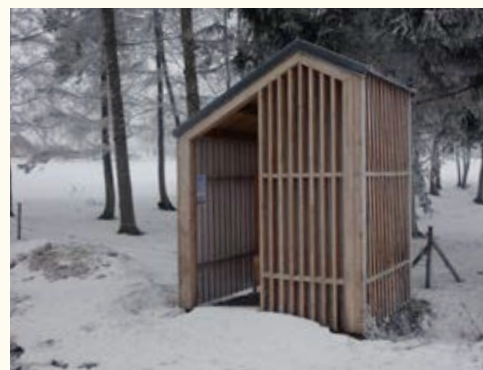
Kvalitně provedená malá zastávka Krahučej – u silnice I/45
