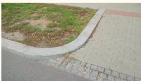
Obrubník s poloměrem 1 m Brno - ulice Pionýrská
