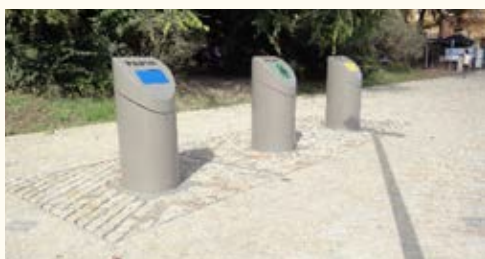
Dokonale materiálově i barevně začleněné podzemní kontejnery Znojmo
