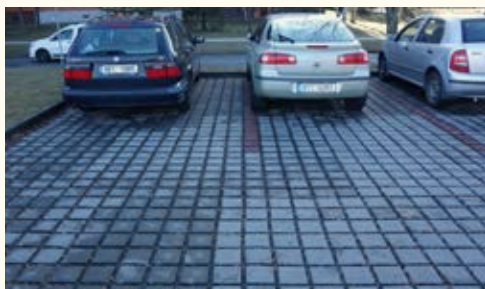
Parkovací plocha z distanční dlažby Krnov - Sídliště pod Čvilínem
