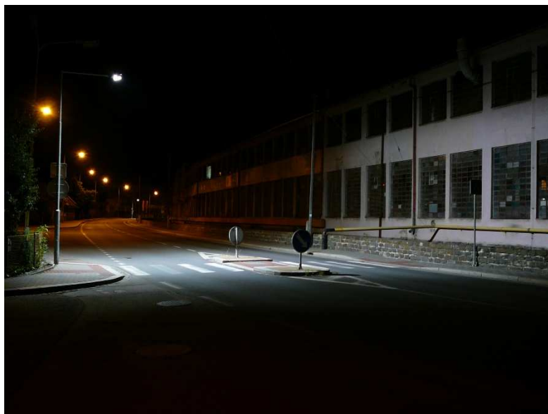
Obr. 68 – Nevyhovující nasvětlení přechodu jedním stožárem (svítidlem)
