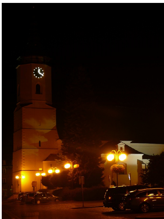
Obr. 84 – nasvícení věže kostela sv. Mikuláše, jižní pohled
