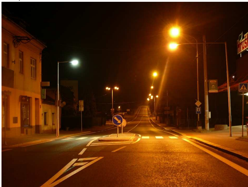
Obr. 67 – Nevhodná volba zdrojů - metalhalogenidový x sodíkový zdroj (přechod u OC Hruška)
