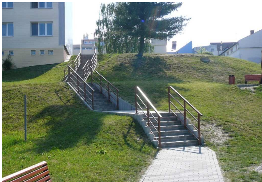
Obr. 54 – Dětské hřiště Radotínská – schody dolní pohled
