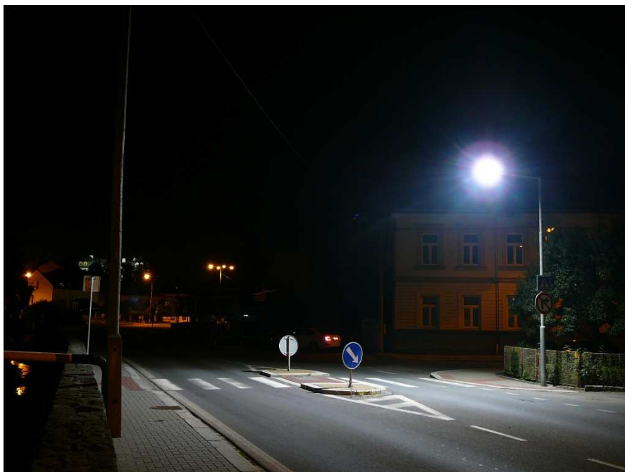
Obr. 79 – výrazně oslňující svítidlo pro chodce i řidiče na přechodu pro chodce
