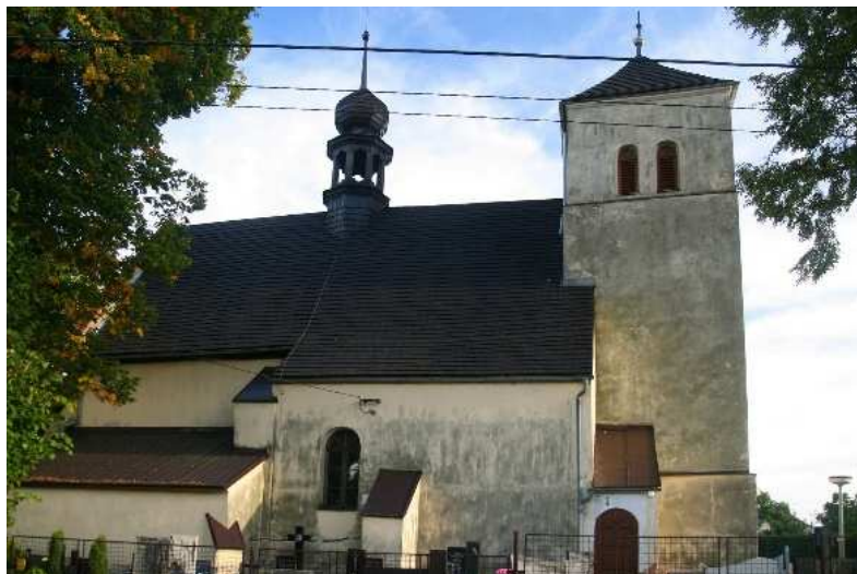
Obr. 101 - Pohled na kostel z levé strany při příjezdu od Bílovce (Zdroj: www.mapy.cz )
