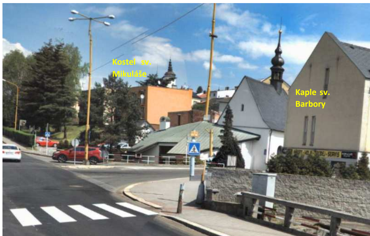
Obr. 31 – pohled od křižovatky Nová Cesta x Čs. armády denní pohled
