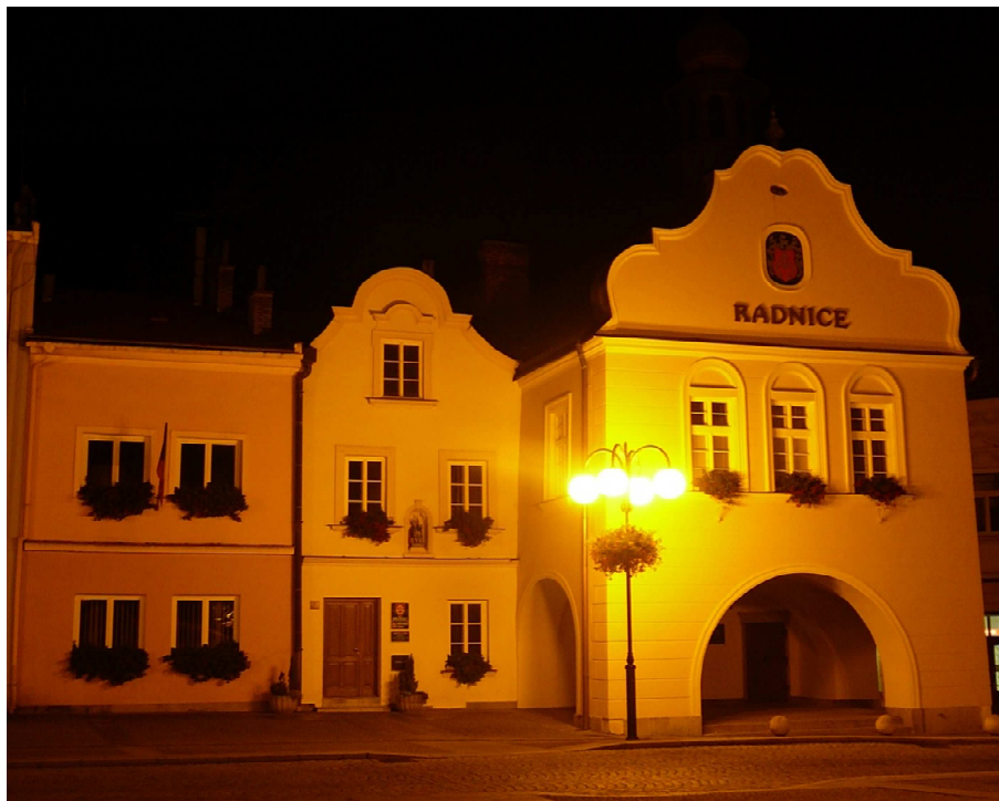
Obr. 93 – současné nasvícení budovy radnice
