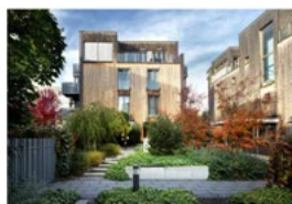
↑ Vnitroblok obytného souboru Na Vackově, Praha, zdroj: UNUT architekti, foto: Tomáš Rádl
