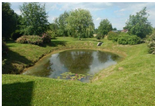
↑ Reteční dešťová nádrž se stálou hladinou, Praha – Čestlice, zdroj: POVIS
