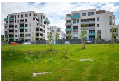
↑ Vsakovací retenční nádrž, SUOMI Hloubětín, Praha, zdroj: Adapterra Awards, foto: Vojta Herout
