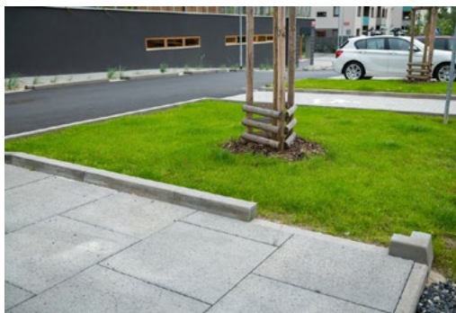
↑ Úprava obrubníku pro nátok do plošného vsaku, Hloubětín, Praha, zdroj: Adapterra Awards, foto: Vojta Herout
