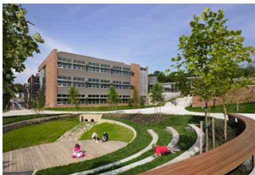
↑ Suchá retenční nádrž jako součást veřejného prostranství před základní školou, Manassas Park, Virginia, USA, zdroj: OWSW Architects, VMDO Architects a foto: Prakash Patel
