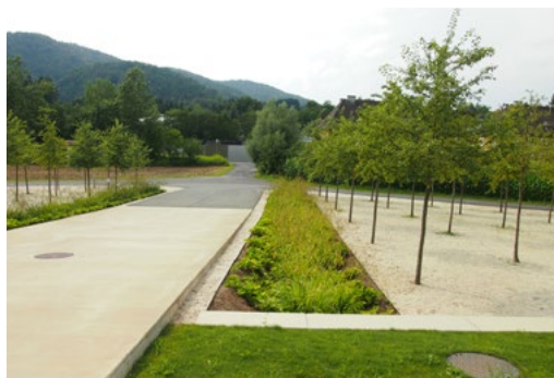
↑ Osázený vsakovací průleh, FBS Warmbad, Villach, Rakousko, foto: autor
