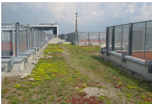
↑ Extenzivní zelená střecha, areál Masarykovy univerzity Brno-Bohunice, zdroj: Atelier Zdenka Sendlera, foto: Zdenek Sendler
