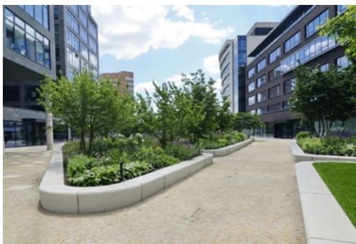
↑ Intenzivní, pobytová zelená střecha, Office park Vlněna, Brno, zdroj: SZUZ, foto: CTP
