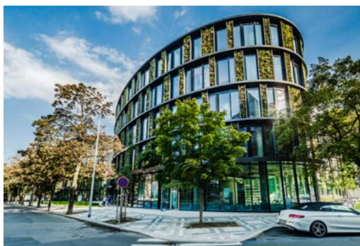
↑ Vertikální záhony jako fasáda, budova Butterfly, Karlín, Praha, zdroj: CMCARCHITECTS, foto: Tomáš Malý
