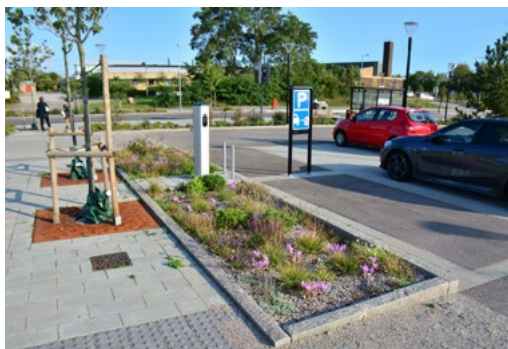
↑ Osázená vsakovací retenční rýha s podpovrchovým přítokem, Vellinge, Švédsko, zdroj: Atelier Edge, foto: Martin Vysoký
