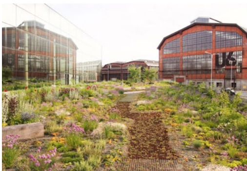
↑ Polointenzivní zelená střecha, Velký svět techniky, areál Dolní Vítkovice, zdroj: foto autor
