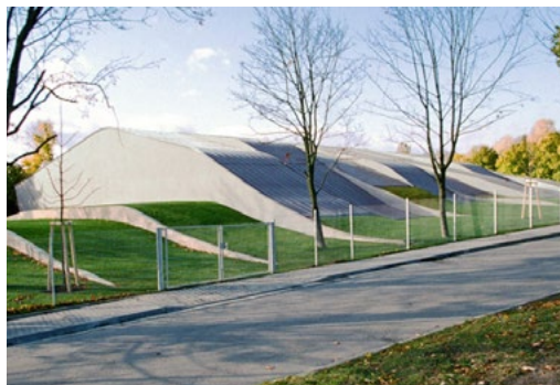
↑ Plavecký bazén – vegetační střecha, Litomyšl, zdroj: Architekti DRNH, foto: Tomáš Malý
