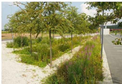
↑ Příklad smíšeného záhonu, vsakovací průleh v areálu školy, FBS, Warmbad, Villach, Rakousko, zdroj: foto autor
