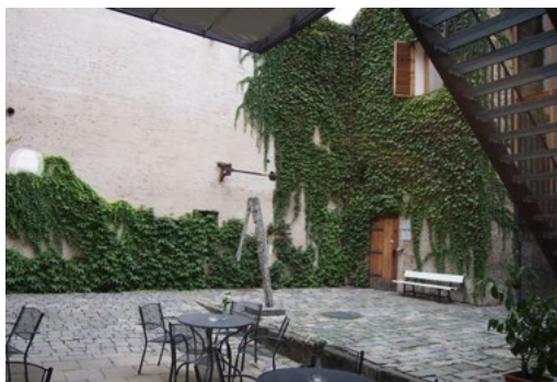
↑ Popínavky bez opěrné konstrukce, zákoutí v Litomyšli, zdroj: foto autor
