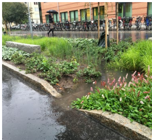
↑ Lokální snížení obrubníku, Strandbogatan, Uppsala, Švédsko, zdroj: atelier Edge, foto: Martin Vysoký
