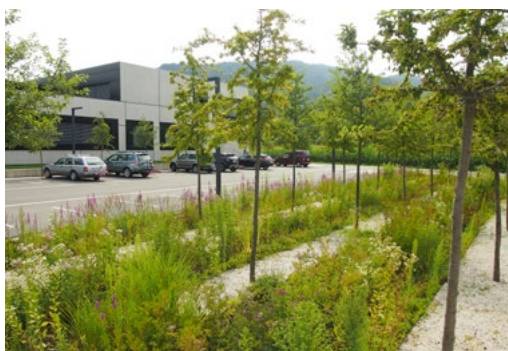
↑ Osázená vsakovací retenční rýha s povrchovým přítokem, FBS Warmbad, Villach, Rakousko, foto: autor
