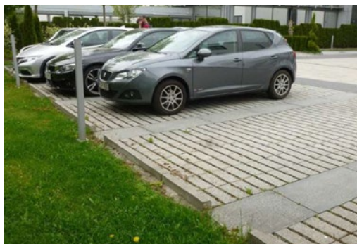
↑ Úprava obrubníku pro nátok do plošného vsaku, Mnichov, Německo, zdroj: POVIS, foto: Ivana Kabelková
