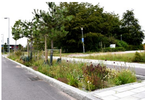
↑ Osázená vsakovací retenční rýha s podpovrchovým přítokem, Vellinge, Švédsko, zdroj: Atelier Edge, foto: Martin Vysoký
