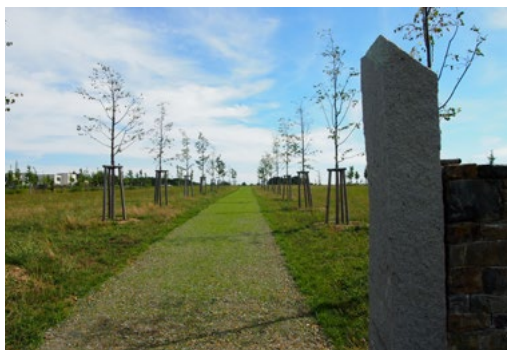
↑ Šterkový trávník těsně po založení, cesta na hřbitově v Dolních Břežanech, zdroj: foto autor
