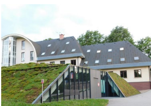
↑ Šikmá extenzivní zelená střecha, KRTEK – Krkonošské centrum environmentálního vzdělávání, Vrchlabí, zdroj: foto autor
