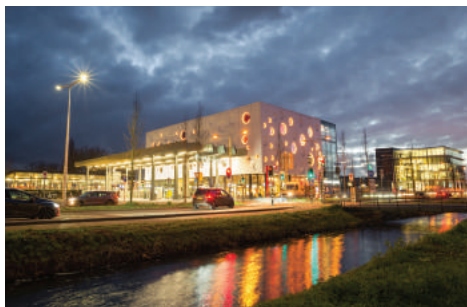
Obchodní centrum a kancelářské budovy
