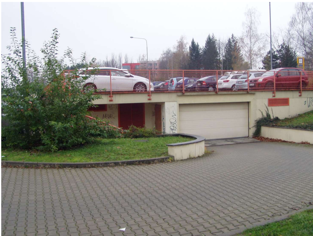
Obrázek 150: Dvoupodlažní napůl zapuštěná garáž s celkovou kapacitou 50 stání, Ostrava, ulice B. Nikodéma
