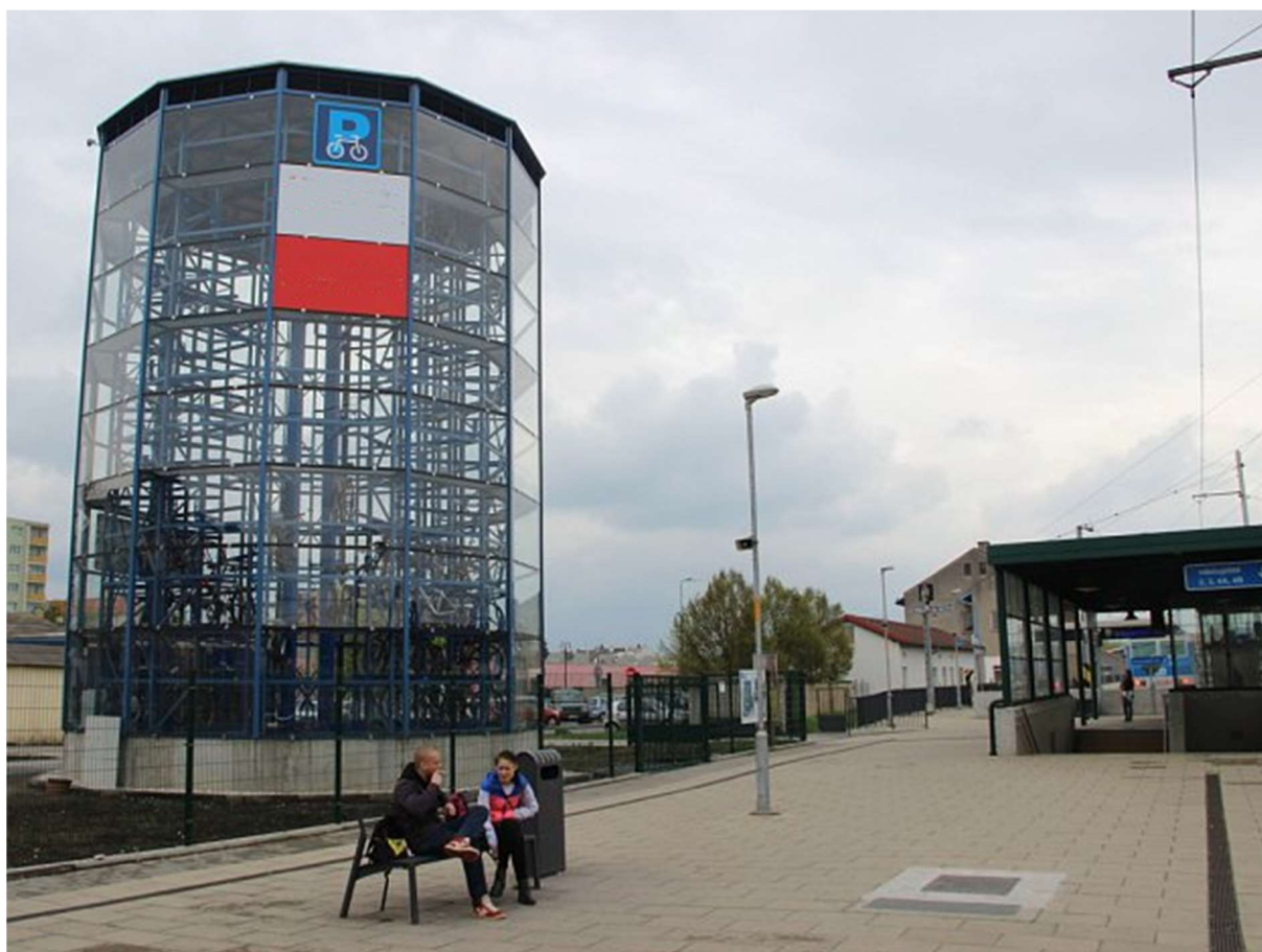
Obrázek 134: Příklad parkovacího domu kol u nádraží Přerov s kapacitou 118 kol, náklady zhruba 10 mil. Kč
