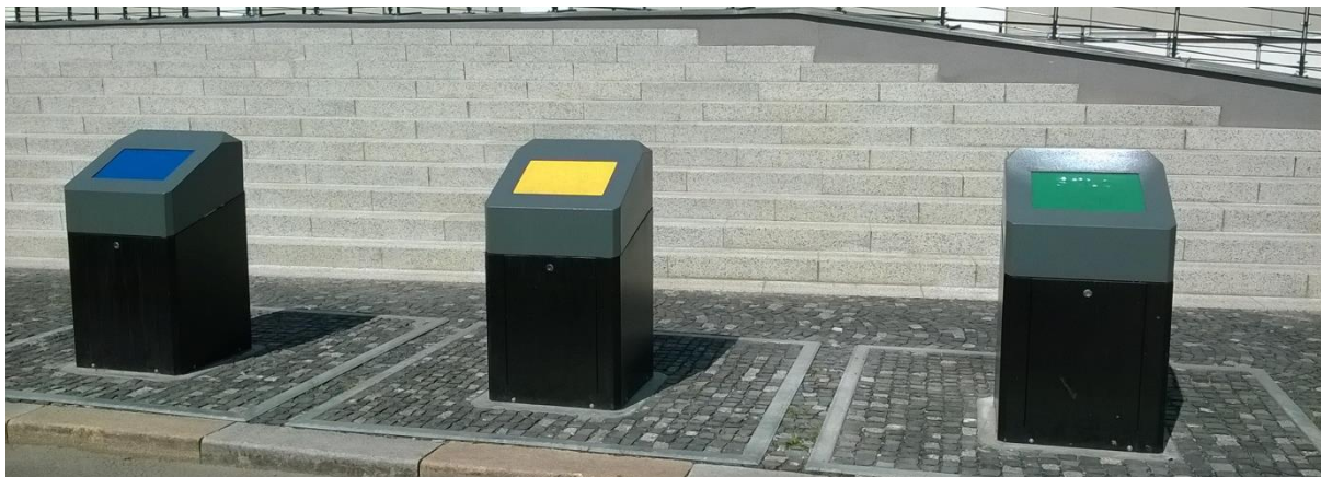
Obrázek č. 13 – Podzemní kontejnery
