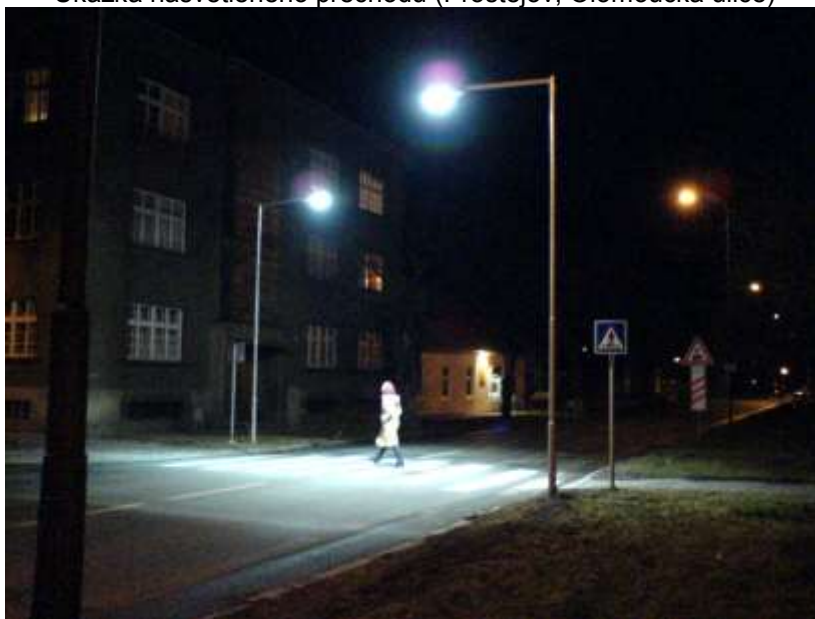
Ukázka nasvětleného přechodu (Prostějov, Olomoucká ulice)
