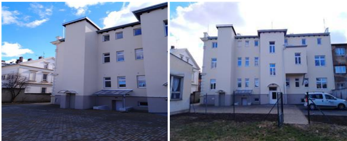
Obrázek 9 Nově vybudované zázemí sociálních služeb Slezské Diakonie, Krnov
