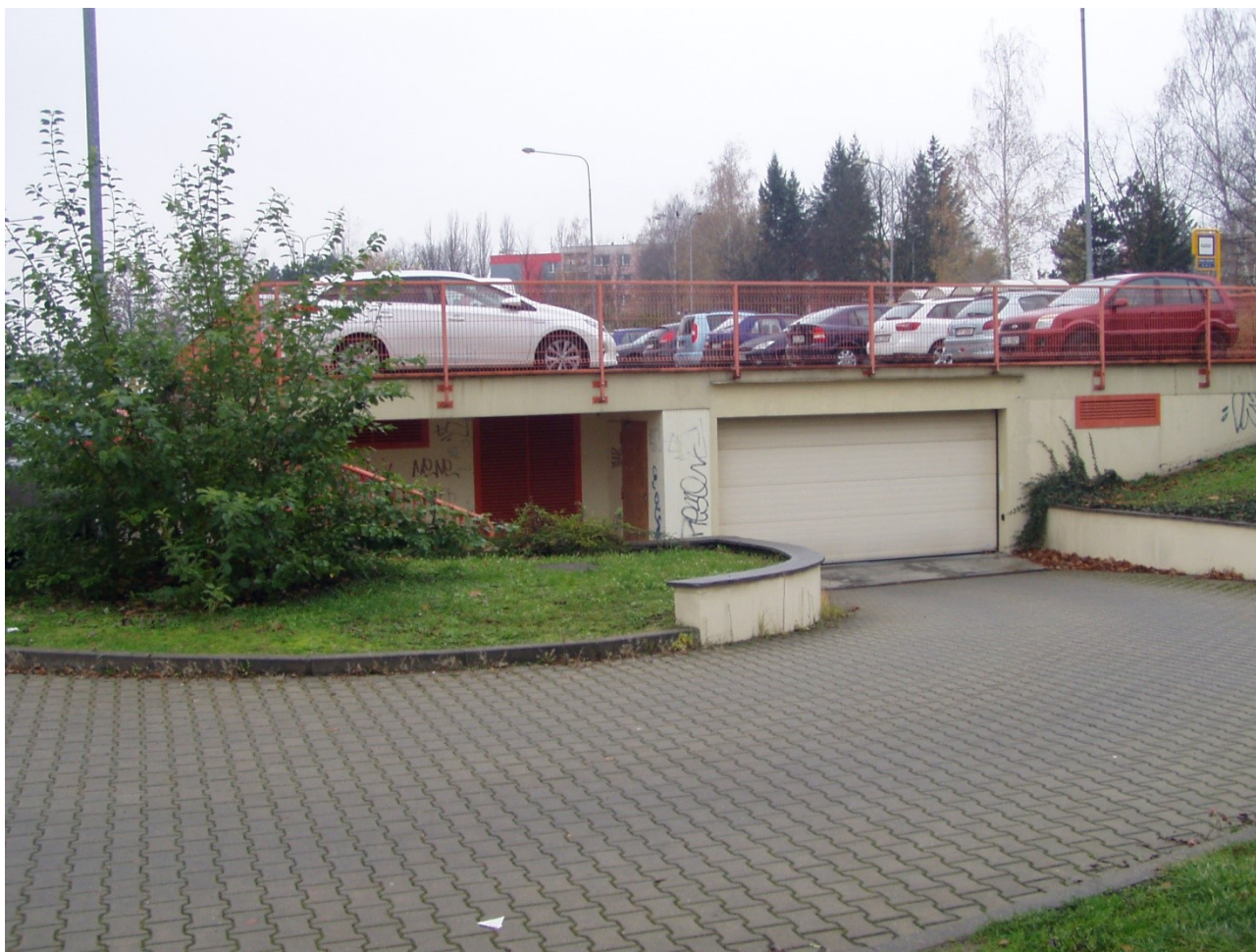
Obrázek 49: Dvoupodlažní napůl zapuštěná garáž s celkovou kapacitou 50 stání, Ostrava, ulice B. Nikodéma
