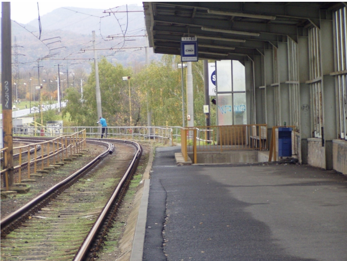
Obrázek 96: Nástupiště a pěší trasa tramvajové zastávky Záluží Petrochemie
