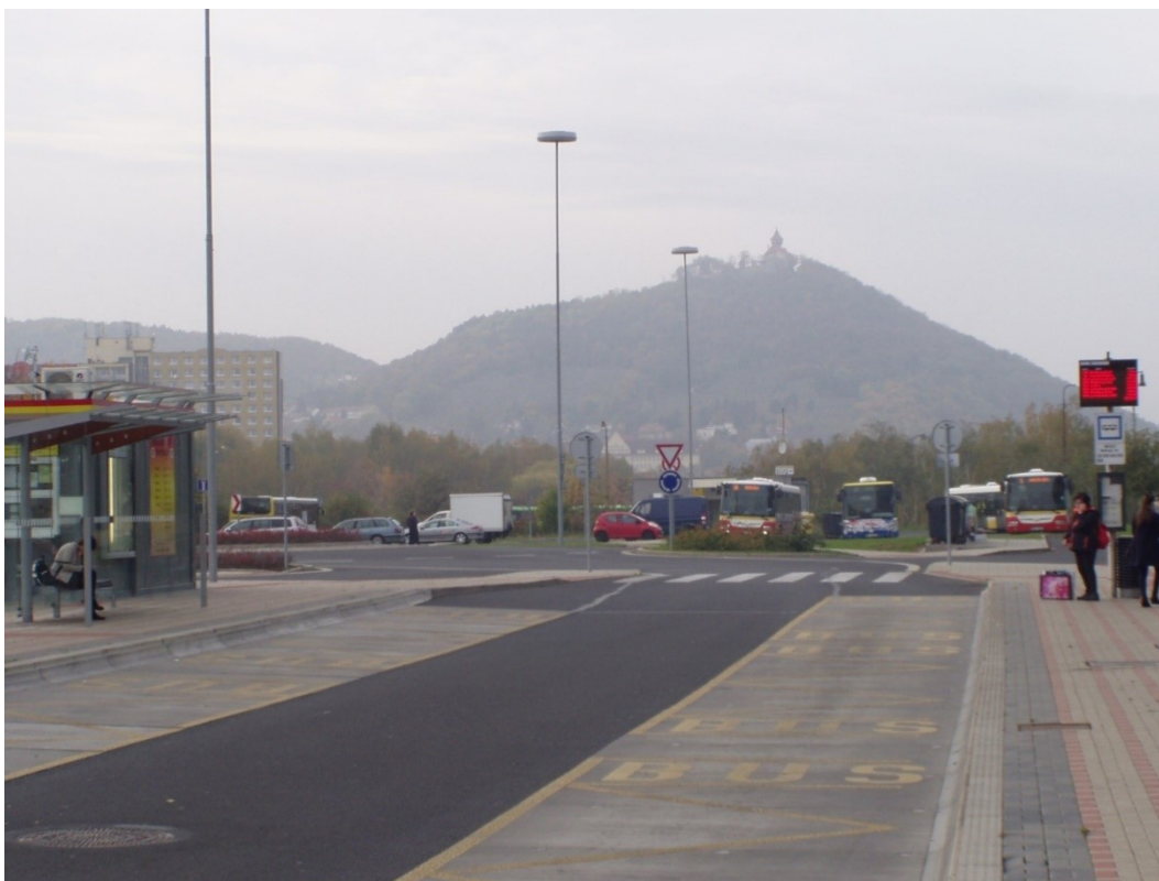
Obrázek 25: Potenciální rozvojová oblast pro výstavbu autobusového nádraží Most, území v pozadí
