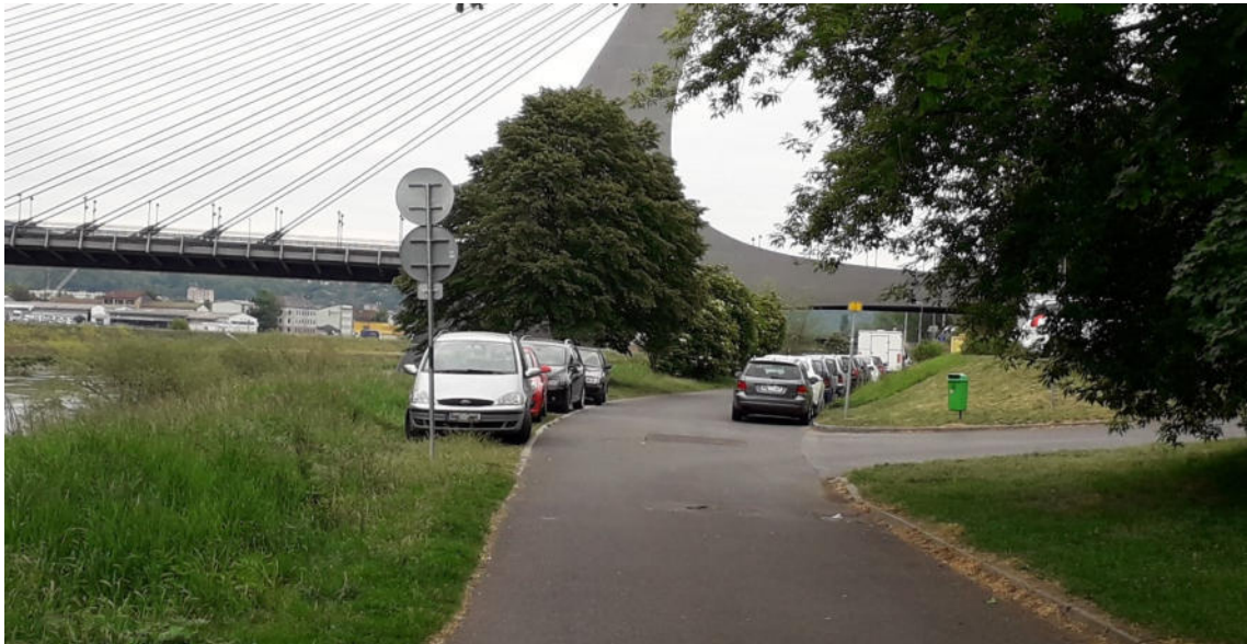
Obrázek 16 Úsek Labské stezky vedený po místní komunikaci - Střekovské nábř. (zdroj: RHDHV)
