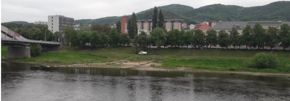
Obrázek 20 Stávající podoba Střekovského nábřeží - pohled od hlavního nádraží (zdroj: RHDHV)
